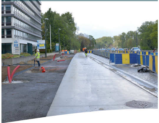
Routes en béton et pavages
