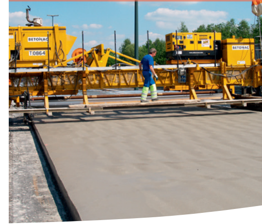
Mise en œuvre
