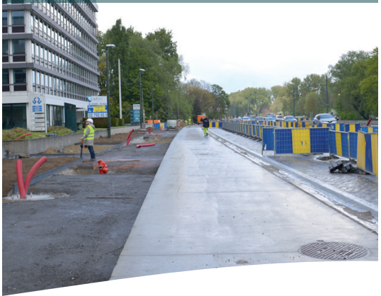
Betonwegen en bestratingen
