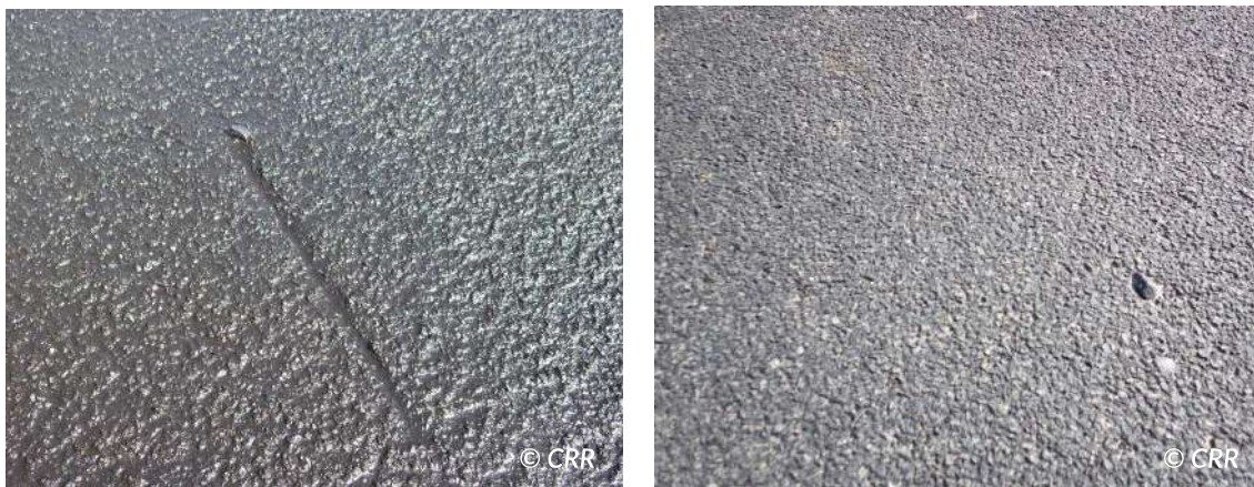
Figure 6.40 – Rainure fermée: à gauche, situation lors de la mise en œuvre, à droite, le même gravillon après un an
