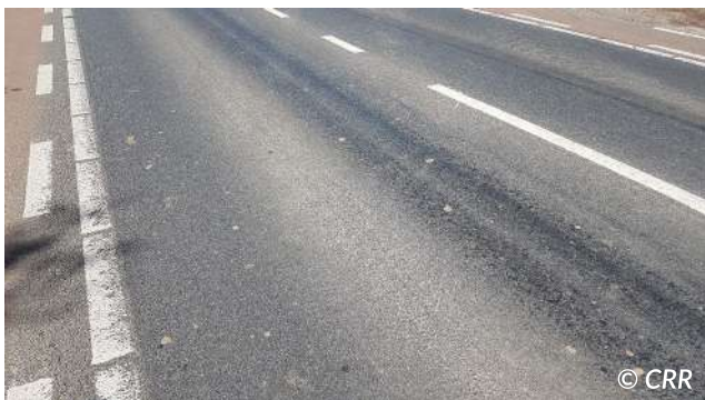
Figure 6.46 – Ressuage dans les frayées de gauche
