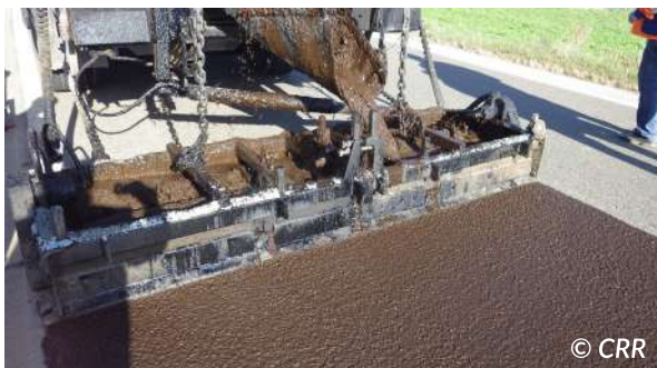
Figure 6.21 – Remplissage du traîneau du côté le plus haut via une goulotte
