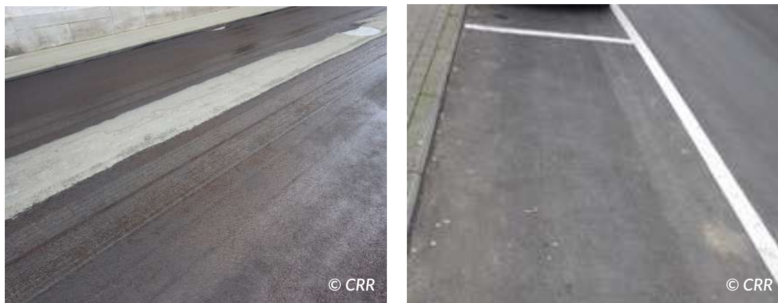
Figure 6.42 – Trace de roue dans un MBCF humide (photo de gauche), qui reste visible même après un an (photo de droite)
