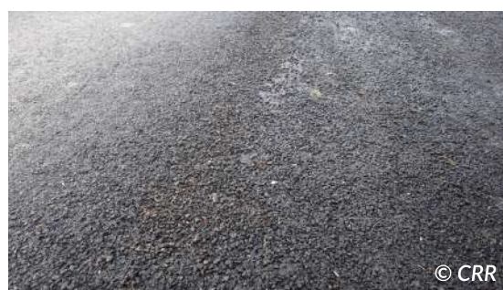
Figure 6.25 – Voie de stationnement où le MBCF a été posé manuellement (photo de gauche); plumage (photo de droite)
