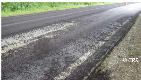
Figure 6.19 – MBCF avec une consistance trop élevée pendant l'exécution
