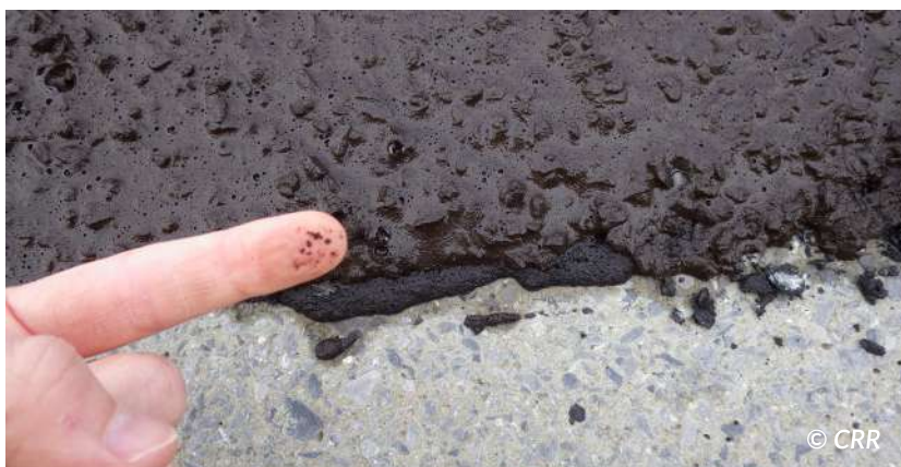
Figure 6.30 – «Test du doigt» dans lequel la phase de mûrissement n'est pas suffisamment engagée, du bitume reste collé au doigt
