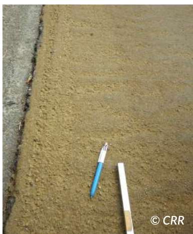
Figure 6.41 – MBCF ocre avec des tôles ondulées transversales
