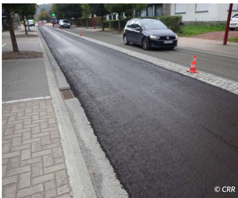
Figure 6.5 – Mise en œuvre par étapes d'un MBCF
