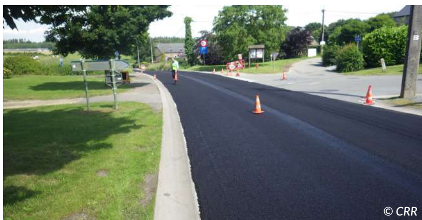
Figure 6.32 – Ouverture de la route après rupture et mûrissement complets
