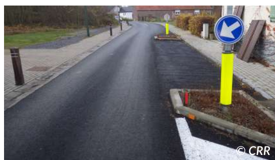
Figure 6.25 – Voie de stationnement où le MBCF a été posé manuellement (photo de gauche); plumage (photo de droite)
