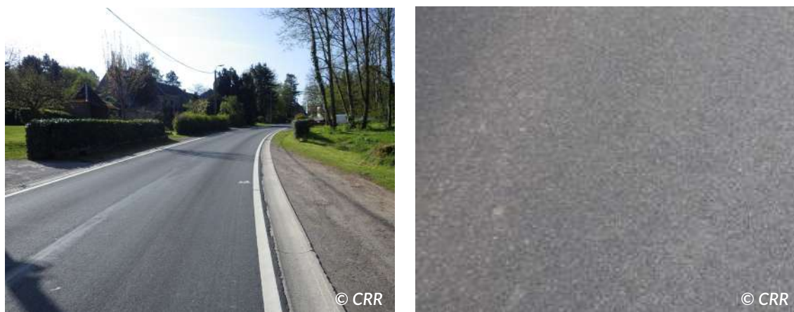
Figure 6.34 – Texture fermée par la circulation un an après la construction
