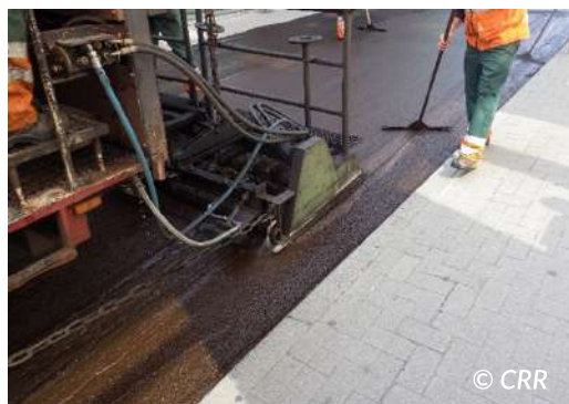
Figure 6.43 – Retouche de la trace laissée par le traîneau
