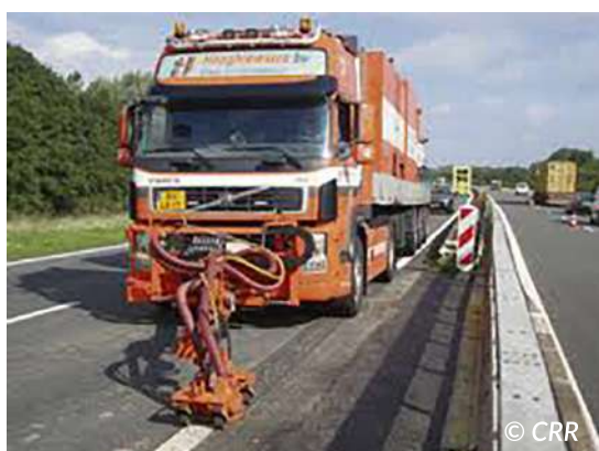
Figure 3.4 - Enlèvement des marquages
