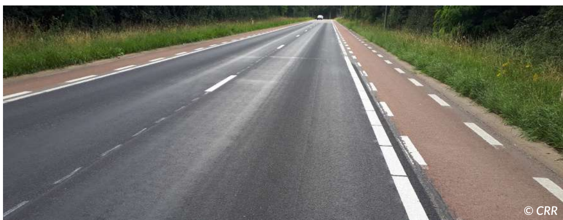
Figure 6.35 – Route avec marquage central: texture plus dense dans les frayées qu'entre les frayées
