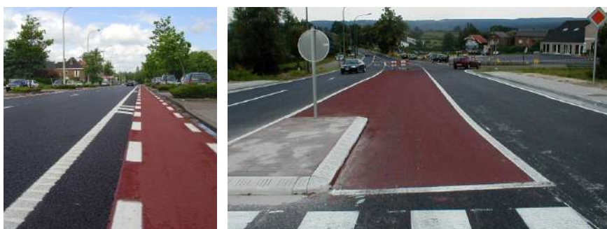
Figure 1.3 – Piste cyclable (à gauche) et îlot (à droite) avec un MBCF rouge (Source: WILLEMEN INFRA NV)
