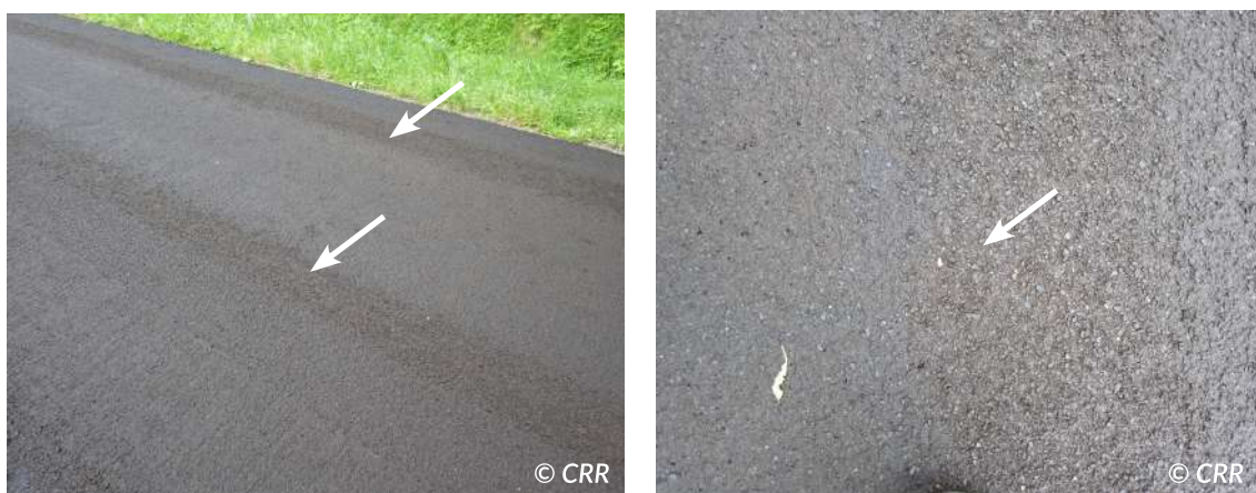
Figure 6.31 – Plumage du MBCF dans les frayées dû à une ouverture prématurée à la circulation
