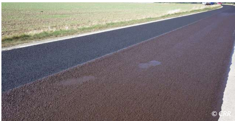
Figure 6.29 – A gauche, MBCF déjà rompu (noir); à droite MBCF (brun) avant la phase de rupture
