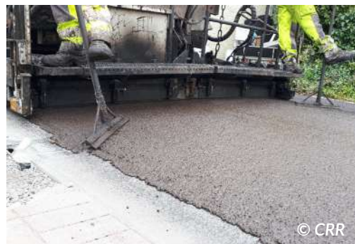
Figure 6.23 – Les bords sont lissés avec des raclettes
