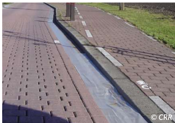
Figure 3.7 – Couverture d'un caniveau à ne pas traiter
