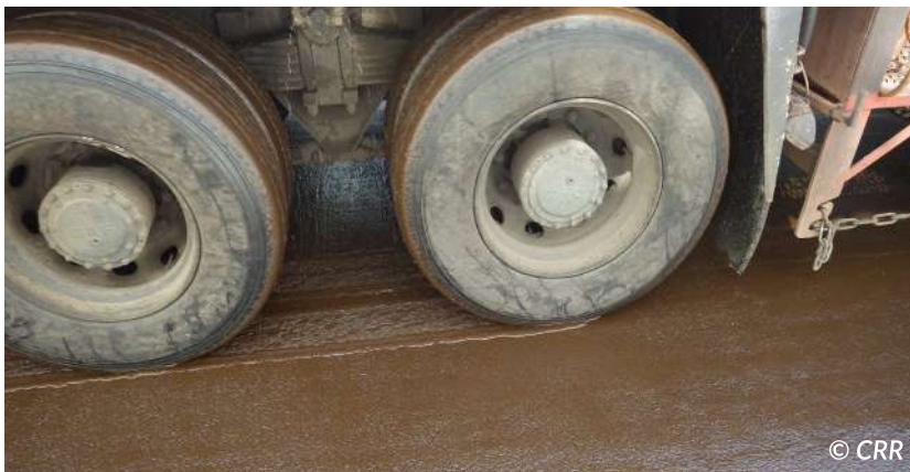
Figure 6.26 – Camion roulant sur un MBCF frais
