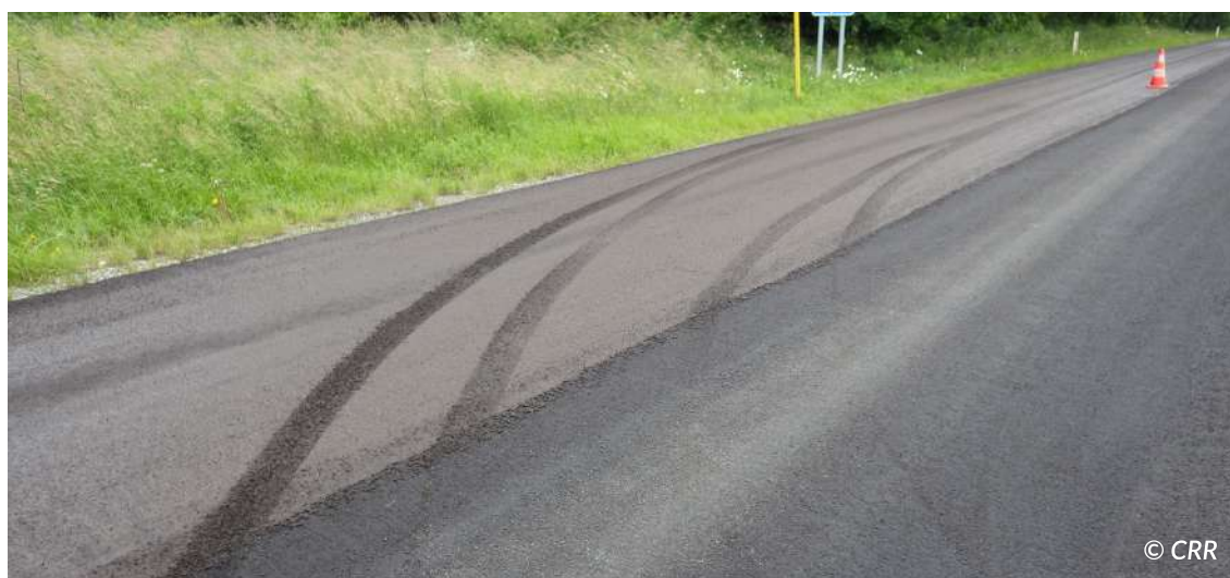
Figure 6.6 – Trace de pneu dans un MBCF frais
