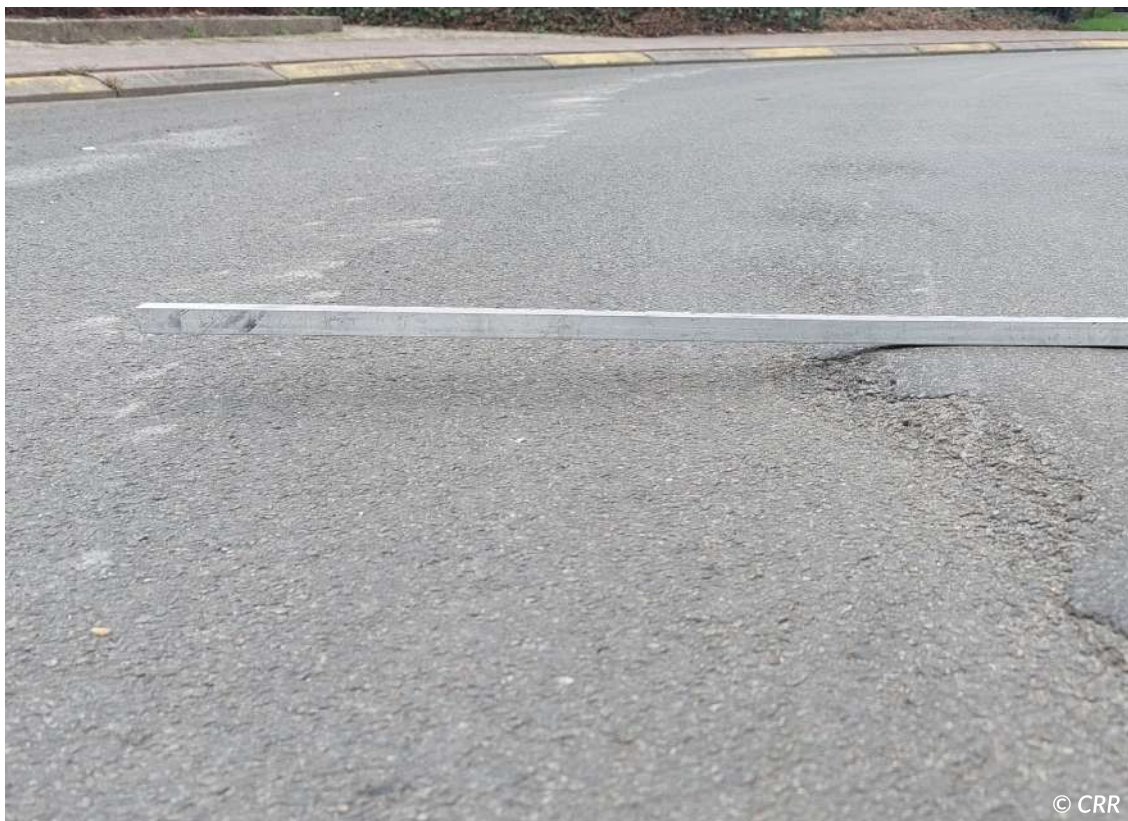
Figure 6.48 – Formation de bosse en raison du changement d'axe imposé par le rond-point
