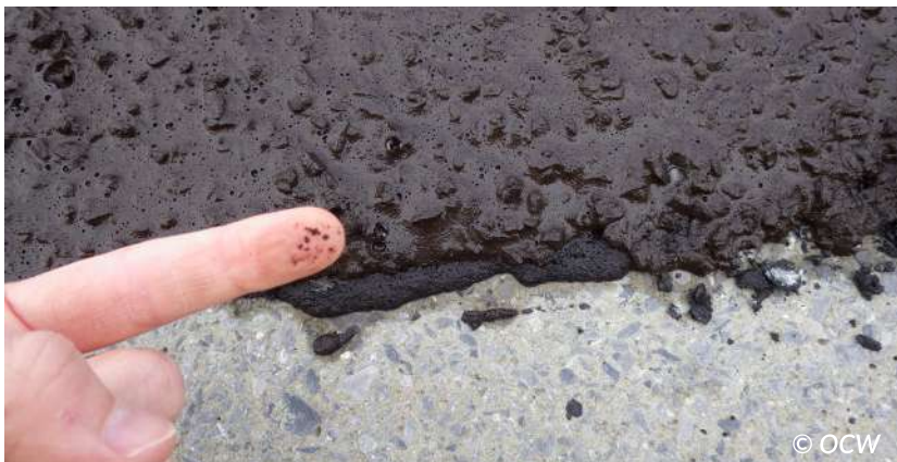
Figuur 6.30 – Vingertest waarbij rijpingsfase onvoldoende is ingezet, bitumen kleeft aan vinger
