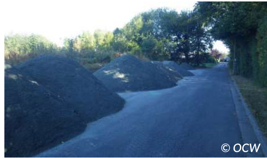
Figuur 6.1 – Stock van aggregaten op onverharde (links) en op verharde (rechts) ondergrond
