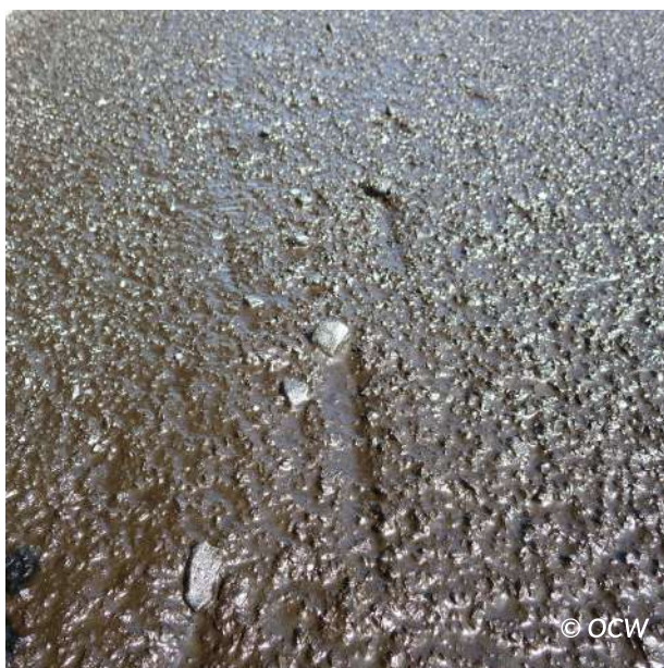
Figuur 6.39 – Groeven door grote stenen vlak na de aanleg van de slemlaag
