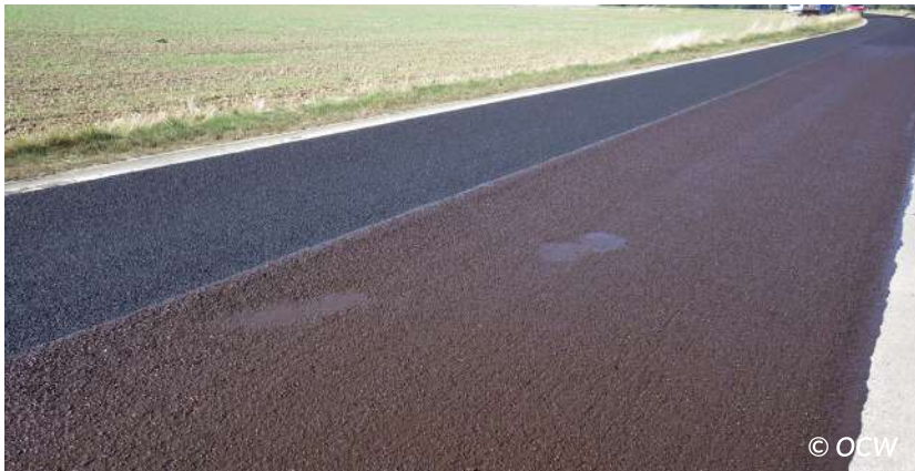
Figuur 6.29 – Links reeds gebroken slem (zwart), rechts bruine slem voor de brekingsfase
