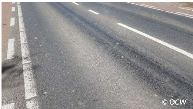
Figuur 6.46 – Zweeten in de linkerwielsporen
