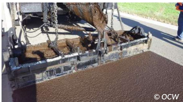
Figuur 6.21 – Slemslede vullen aan hoogste zijde via stortteut
