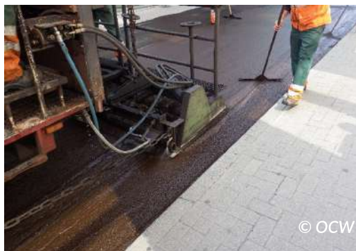
Figuur 6.43 – Sleepspoor van de slede wordt bijgewerkt
