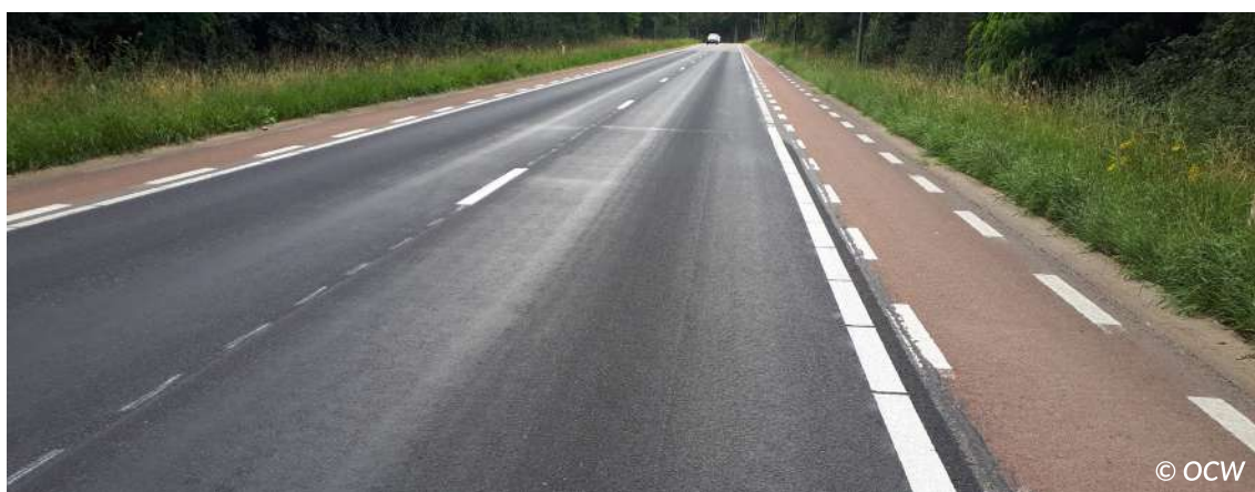
Figuur 6.35 – Weg met middenmarkering: textuur meer dichtgereden in de wielsporen dan tussen de wielsporen
