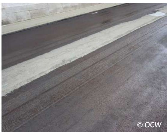
Figuur 6.42 – Wielspoor in natte slem (links), blijft zichtbaar, ook na één jaar (rechts)
