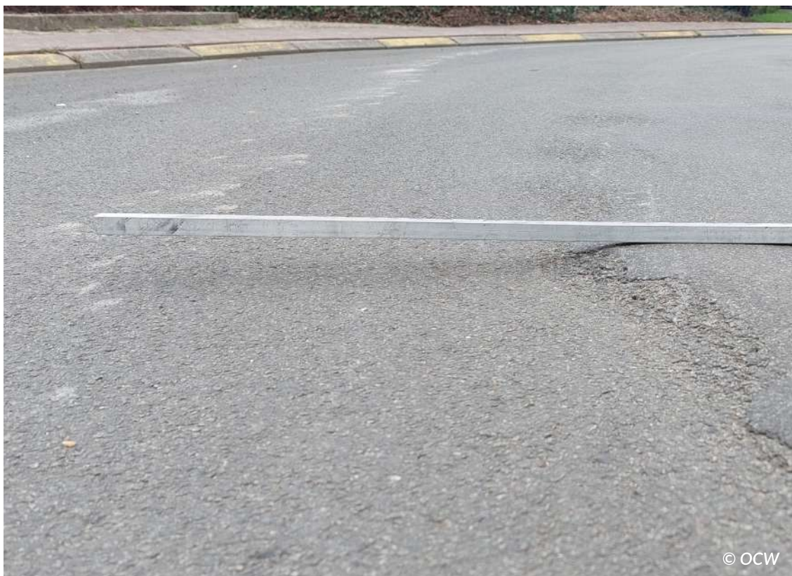
Figuur 6.48 – Bultvorming door verschuiving op een rotonde
