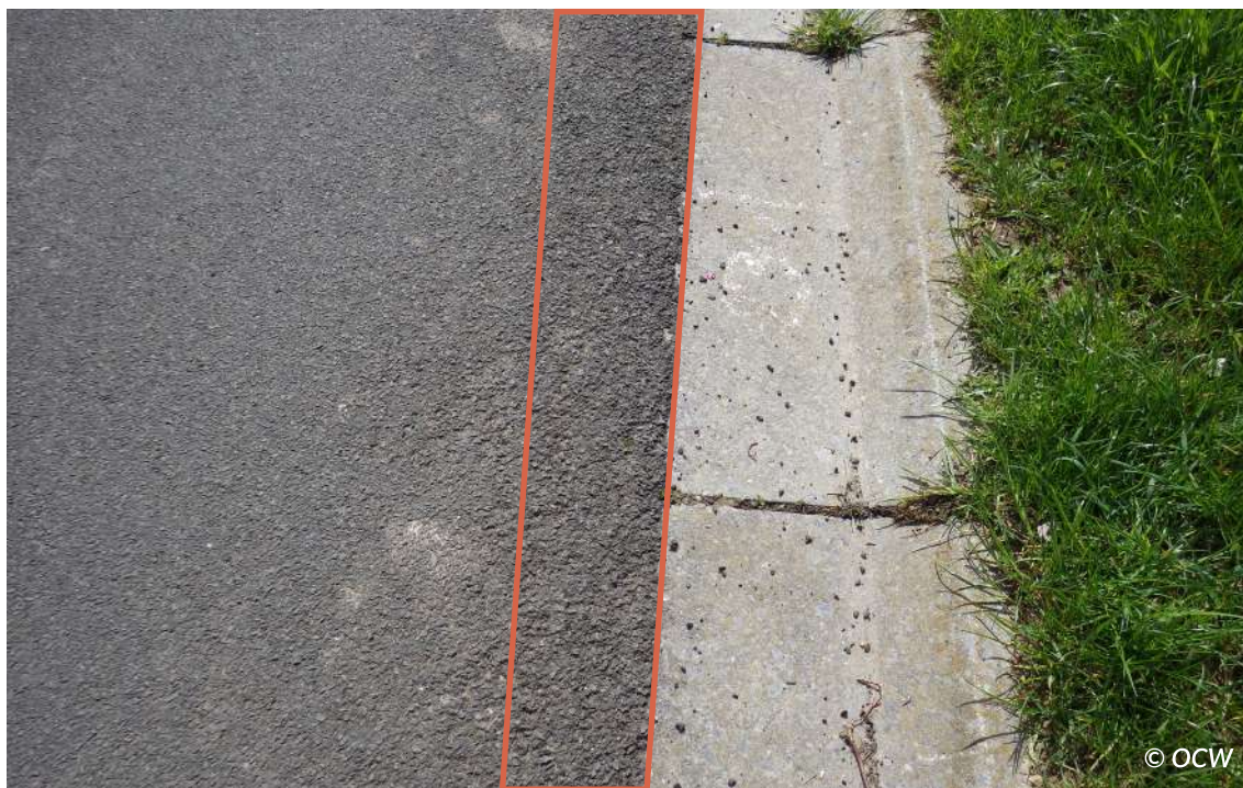
Figuur 6.36 – Weg met open en ruwe randzone in de slemlaag
