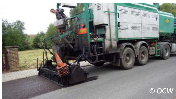
Figuur 6.20 – Slemmachine met operator
