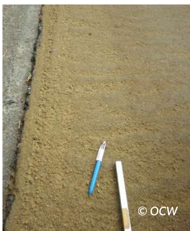
Figuur 6.41 – Okerkleurige slem met dwarse ribbelforming
