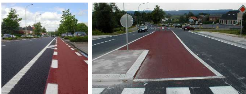
Figuur 1.3 – Fietspad (links) en verkeerseiland (rechts) met rode slem (Bron: WILLEMEN INFRA NV)
