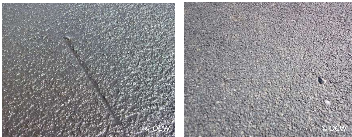
Figuur 6.40 – Dichtgereden groef: links situatie bij aanleg, rechts dezelfde steen na één jaar
