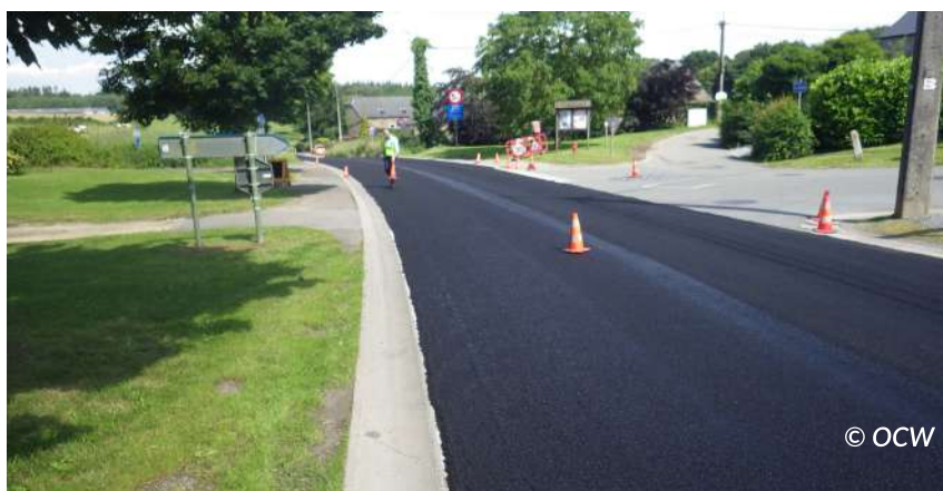
Figuur 6.32 – Openstellen van de weg na volledige breking en rijping
