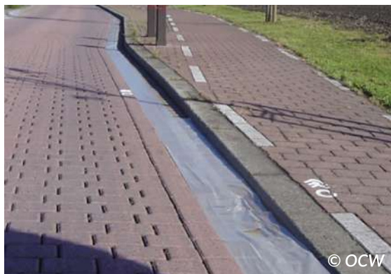
Figuur 3.7 – Afdekken niet te behandelen goot
