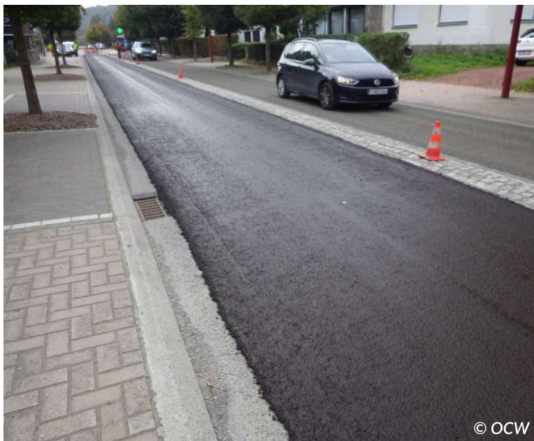
Figuur 6.5 – Gefaseerde aanleg slem
