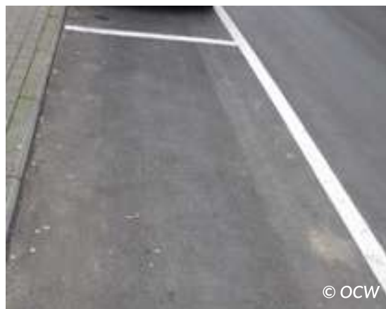
Figuur 6.42 – Wielspoor in natte slem (links), blijft zichtbaar, ook na één jaar (rechts)
