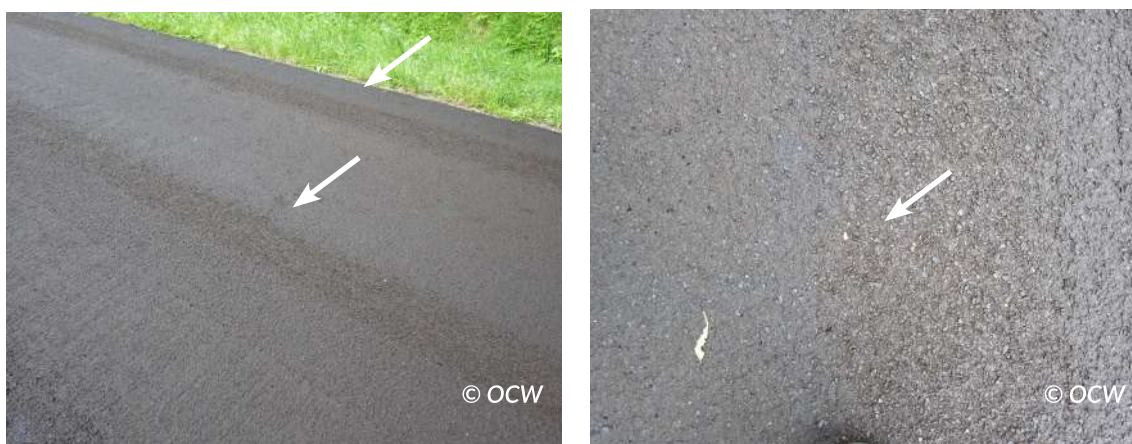
Figuur 6.31 – Rafeling van de slem in de wielsporen door te vroege openstelling voor het verkeer
