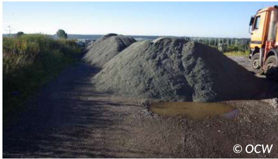
Figuur 6.1 – Stock van aggregaten op onverharde (links) en op verharde (rechts) ondergrond
