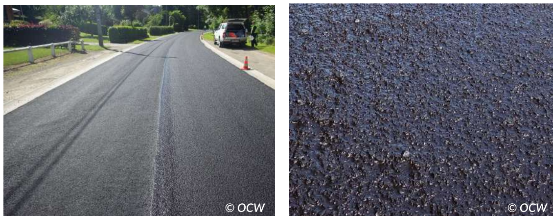
Figuur 6.33 – Ruwe textuur vlak na aanleg en voor openstelling voor verkeer
