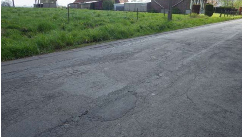
Figuur 7.8 – Wegdek dat het einde van de levensduur heeft bereikt
