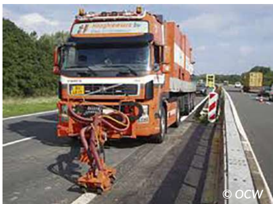
Figuur 3.4 – Verwijderen van wegmarkering
