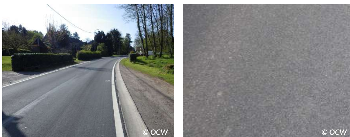
Figuur 6.34 – Dichtgereden textuur door verkeer één jaar na aanleg
