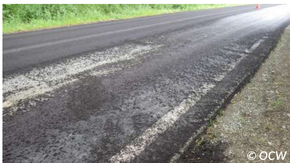
Figuur 6.19 – Slem met te hoge consistentie tijdens de uitvoering
