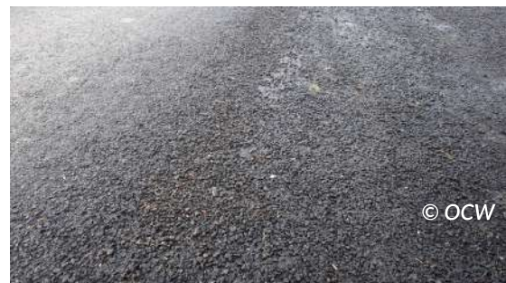
Figuur 6.25 – Parkeerstrook waar de slem manueel werd aangelegd (links); rafeeling (rechts)
