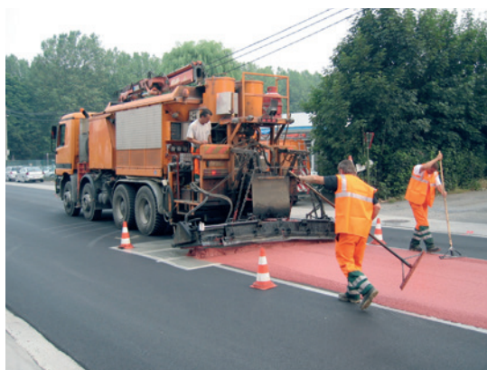
Figure 6.4 – Mise en œuvre d'un MBCF coloré
