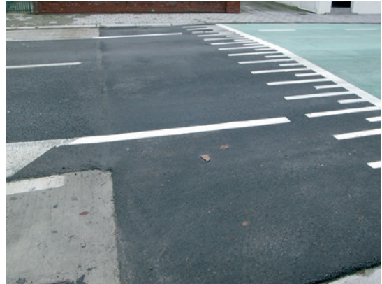
Figure 4.9 – Partie inclinée d'un plateau: travail manuel inévitable, utiliser un enrobé adéquat
