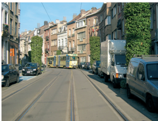
Figure 4.11 – Voie de tram
