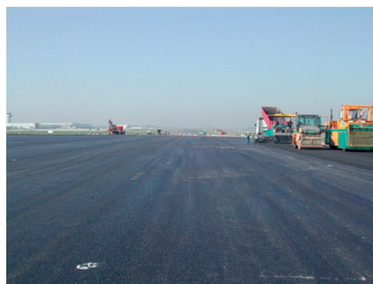
Figure 6.2 – Mise en œuvre d'un grave-bitume
