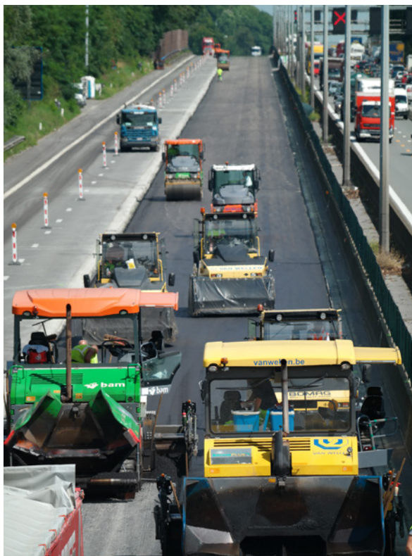
Figure 2.3 – Pose d'un enrobé
