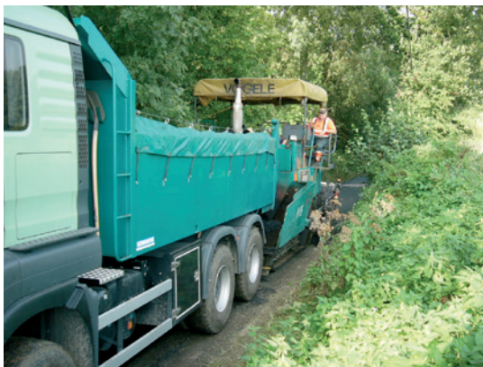
Figure 4.7 – Travaux sur une largeur réduite
