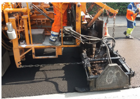
Figure 2.5 – Pose d'un MBCF
