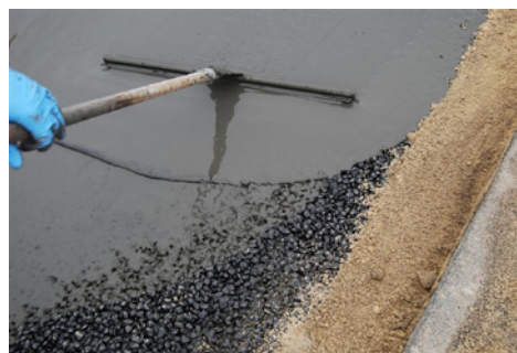
Figure 2.7 – Enrobé percolé: remplissage des pores de l'enrobé avec du coulis
