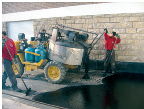
Figure 2.6 – Pose d'un asphalte coulé
