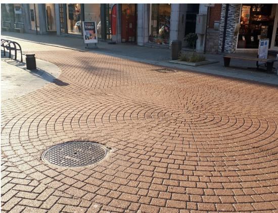
**Figure 4** - Béton bitumineux coloré imprimé
