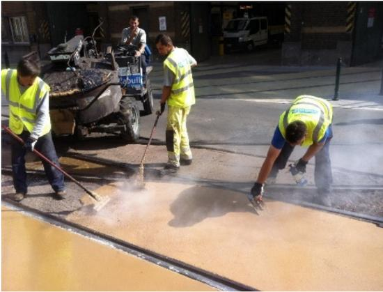
**Figure 3** - Mise en œuvre d'asphalte coulé de couleur ocre (© Viabuild)
