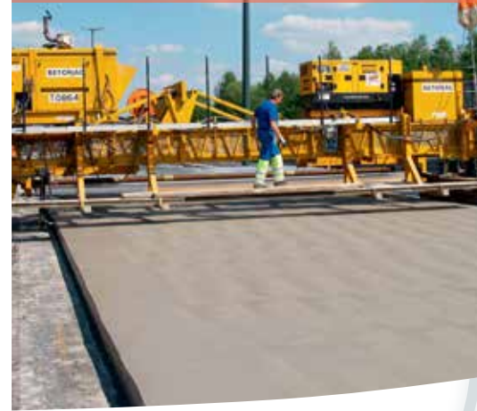
Mise en œuvre
