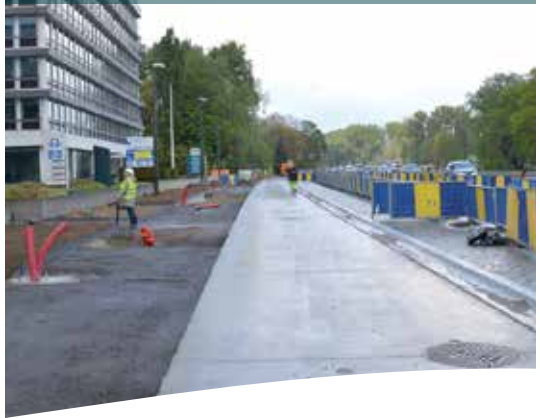
Routes en béton et pavages
