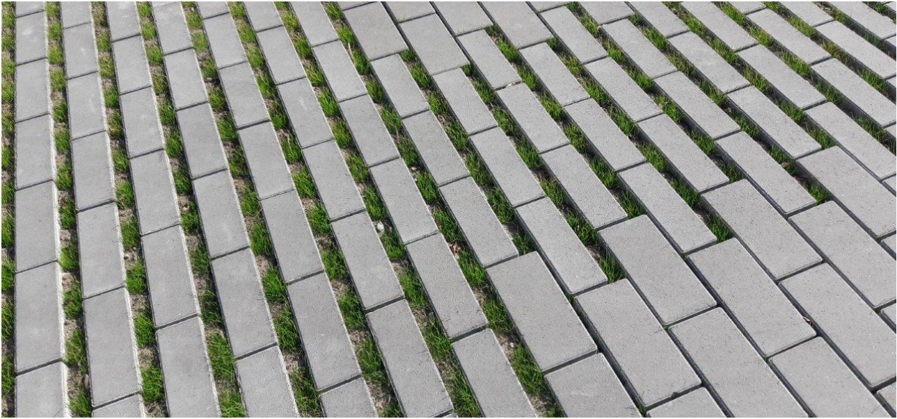
Figuur 8 – Betonstraatstenen met drainageopeningen (Voskenslaan Genk) (Ebema)
