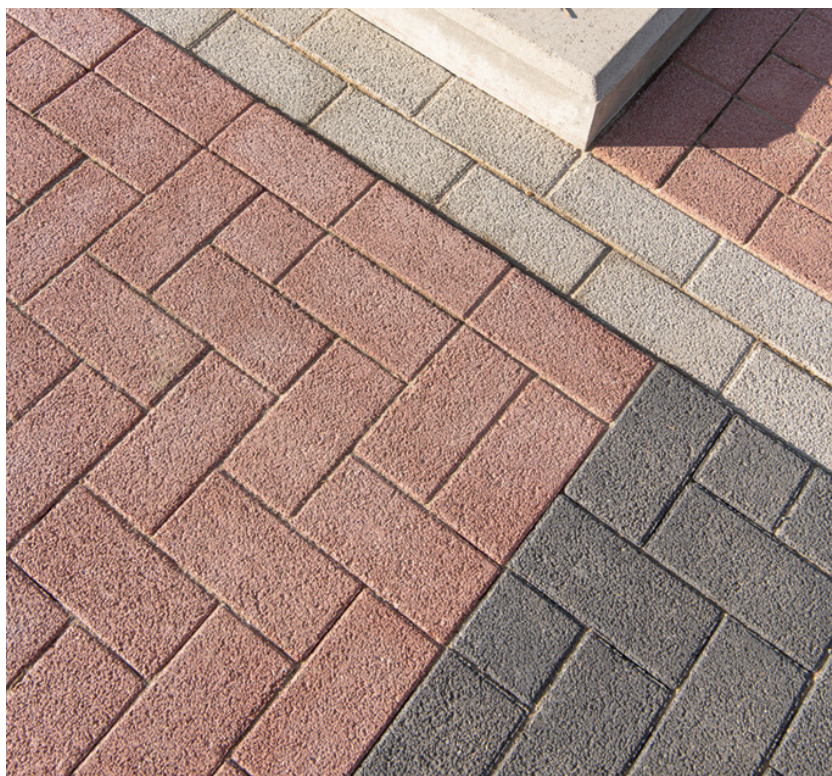
Figuur 6 – Poreuze betonstraatstenen (Parking Brico Plan-it - Ternat) (Stradus, s.d.)
