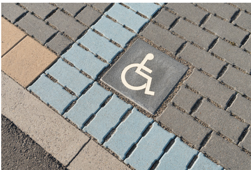
Figuur 7 – Betonstraatstenen met verbrede voegen (Parking Ziekenhuis Maas & Kempen - Maaseik) (Stradus, s.d.)
