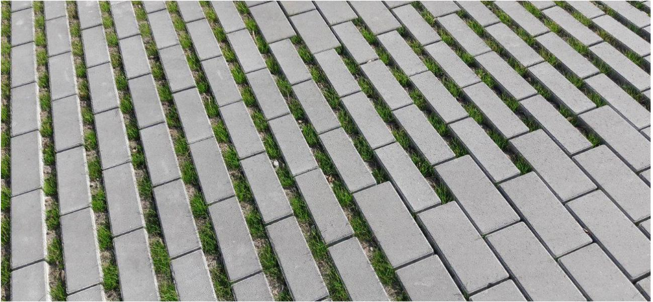
**Figure 8** – Pavés en béton avec ouvertures de drainage (Voskenslaan Genk) (Ebema)
