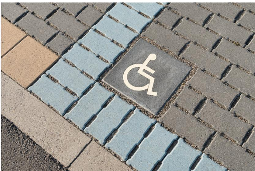
**Figure 7** – Pavés en béton à joints élargis (Parking Hôpital Maas & Kempen - Maaseik) (Stradus, s.d.)
