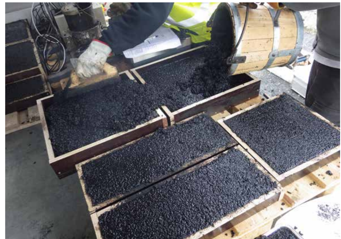
Figuur 8.1 – Het vullen van een houten mal met warm gietasfalt op de bouwplaats
