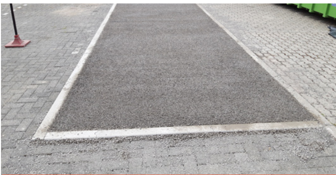
Figuur 1 – Proefvak met poreuze betonverharding op de OCW-terreinen in Sterrebeek
