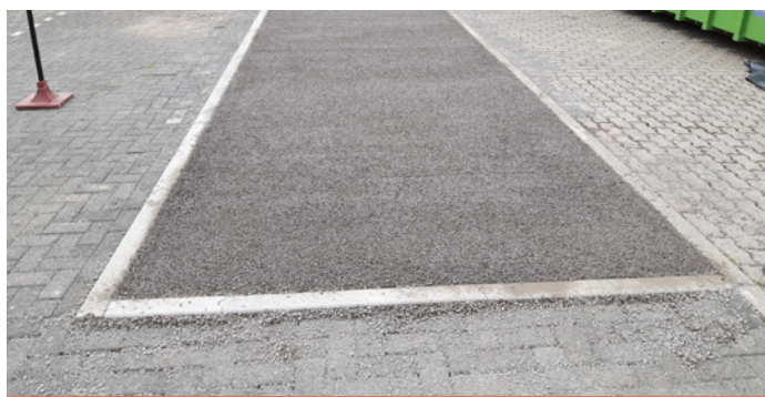
Figure 1 – Planche d'essais avec revêtement en béton poreux sur le site du CRR à Sterrebeek
