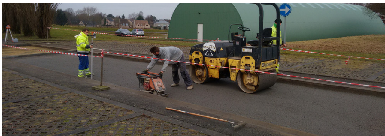
Figure 2 – Application de béton maigre drainant comme fondation sous un revêtement en pierre naturelle
