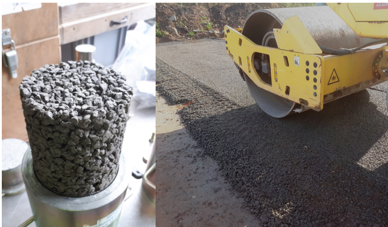
Figure 3 – Recherche d'une méthode de compactage en laboratoire représentative de la situation sur chantier
