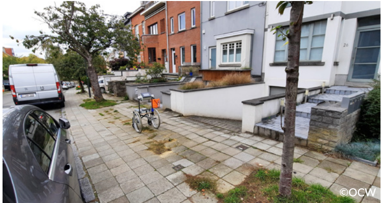
Figuur 4 – Metingen uitgevoerd met de meetstoel op de trottoirs van de Koloniaalleaan in Watermaal-Bosvoorde
