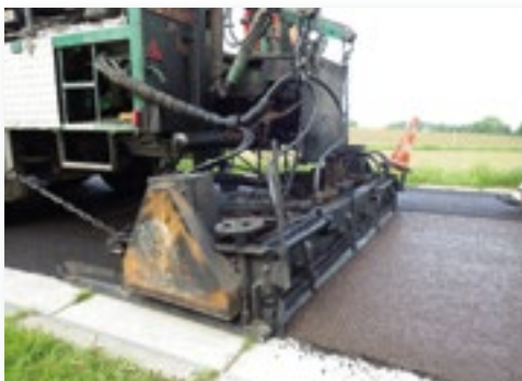
MBCF à l'arrière de la machine
