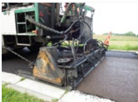
Slem aan de achterzijde van de slemmachine
