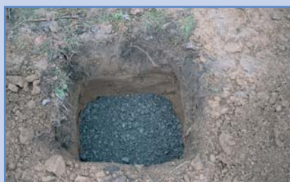
Figure 2.11 Méthode du puits
