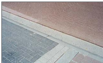
Figure 1.10 Contrebutage entre le trottoir et la chaussée
