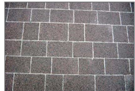
Figure 1.8 Bon remplissage des joints avant ouverture au trafic
