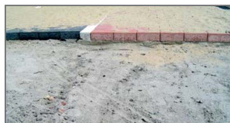
Figure 1.4 Fondation avec couche de pose, pavés et matériau de jointoiment
