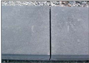
Figure 4.3 Face supérieure anti-éclats d'un contrebutage
