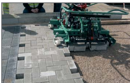
Figure 4.10 Pavage mécanique
