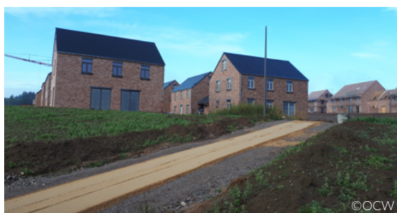
Figuur 3 – Bouwplaats met de uitvoering van een halfverharding in Waver (oktober 2020)
