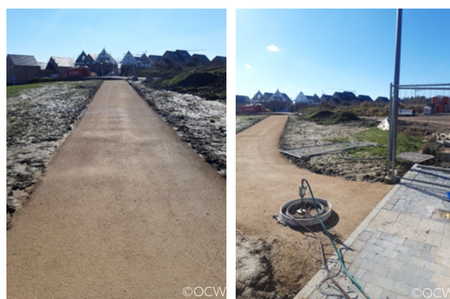
Figuur 4 – Doorlatendheidsmetingen op de bouwplaats in Waver (product F_3-M_2 )
