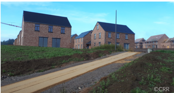
Figure 3 – Chantier de mise en œuvre de revêtement semi-dur à Wavre (octobre 2020)
