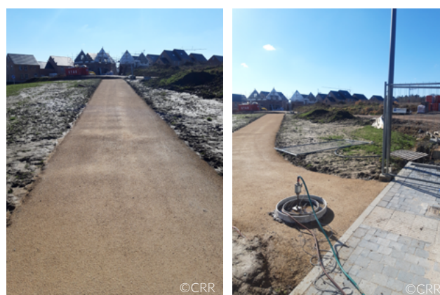
Figure 4 – Mesures de perméabilité sur le chantier de Wavre (produit F 3 -M 2 )
