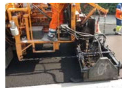
Figuur 2.5 – Aanbrengen van een slem
