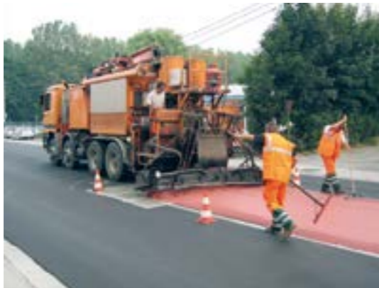
Figuur 6.4 – Aanbrengen van een gekleurde slemlaag
