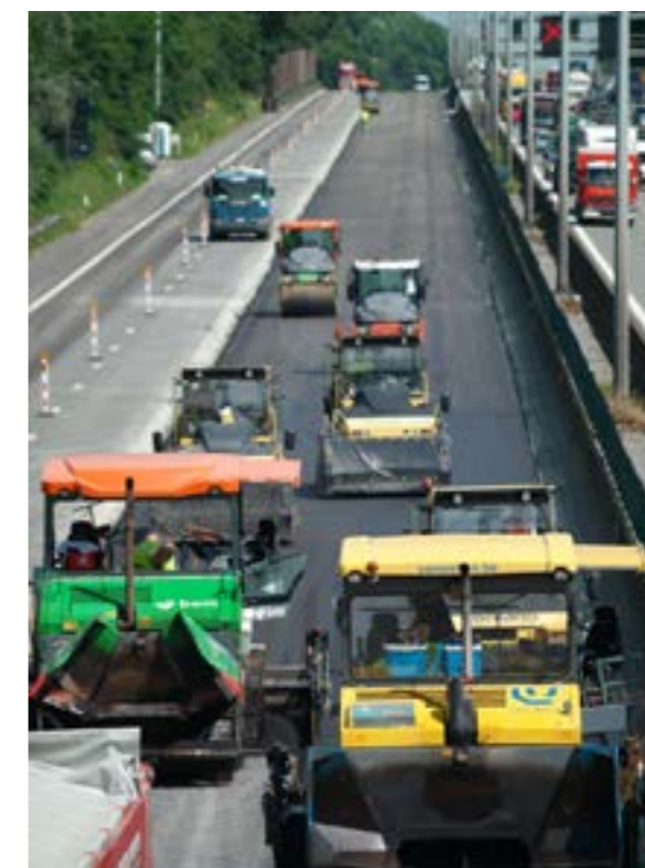
Figuur 2.3 – Aanbrengen van asfalt
