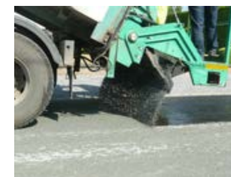
b/ Afstrooien met steenslag
