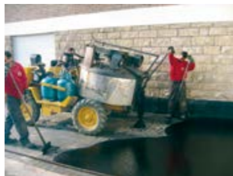
Figuur 2.6 – Aanbrengen van gietasfalt
