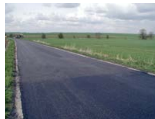
b/ Na aanbrenging
