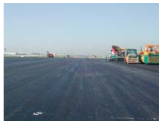
Figuur 6.2 – Aanbrengen van schraal asfalt
