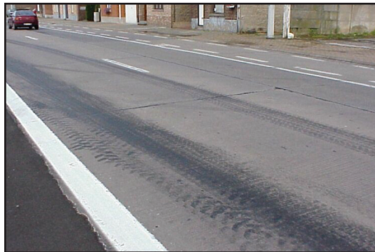
Figuur 4.5 – Oppervlakgebreken kunnen hinderlijk zijn voor het functioneren van zelfrijdende voertuigen
