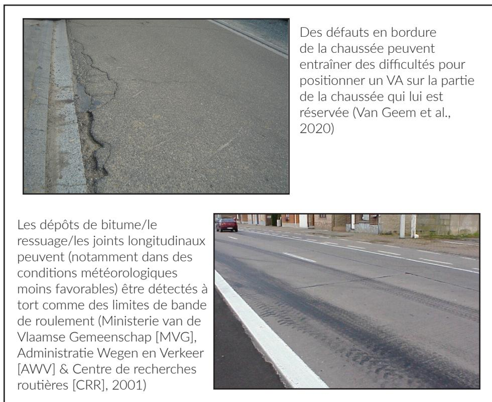
**Figure 4.5** – Les défauts de surface peuvent entraver le fonctionnement des véhicules autonomes
