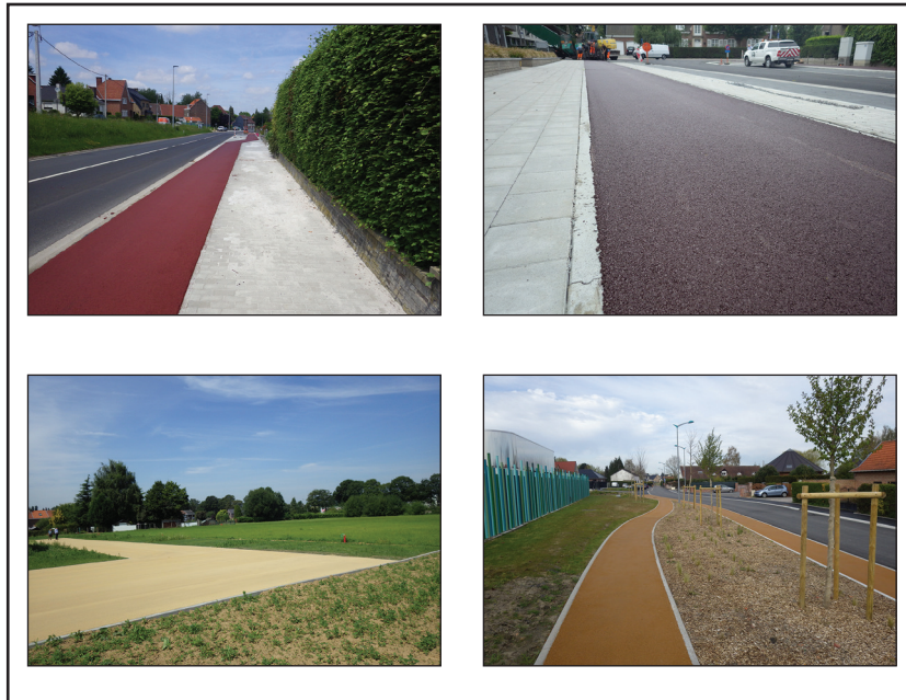
Representatieve bouwplaatsen voor het kleurengamma van de Belgische producenten
