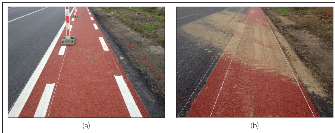
Figuur 2.8 – Twee “beschadigde” vakken met geringe (a) en ernstige (b) verontreiniging door aarde
