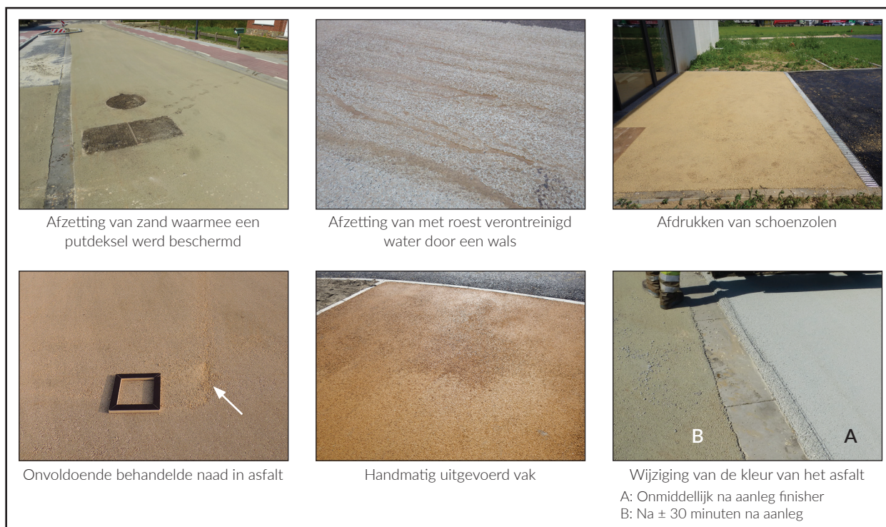
Figuur 2.4 – Enkele factoren die verband houden met de uitvoering zelf en die kleurmetingen op de bouwplaats kunnen bemoeilijken of zelfs verhinderen
