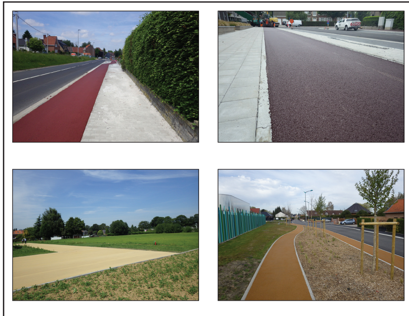
Illustration de chantiers représentatifs de la gamme de couleurs des producteurs belges
