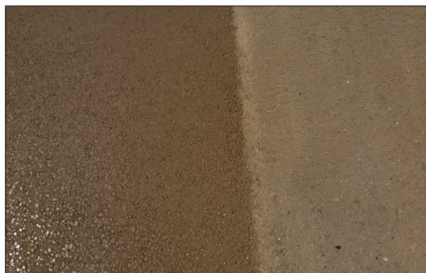
Figure 2.6 – Illustration du changement de teinte de l'enrobé durant son refroidissement (à gauche: 50 °C et à droite: 35 °C)
