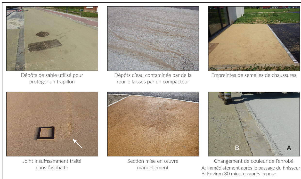
Figure 2.4 – Illustration de certains facteurs liés à l'exécution même qui peuvent compliquer voire empêcher les mesures de couleur sur chantier
