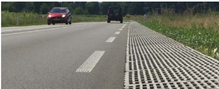
Figuur 1 – Geprefabriceerde betonnen diffractoren, ingewerkt in de grond. Hummelo, provincie Gelderland, Nederland, 2015 (4SILENCE)
