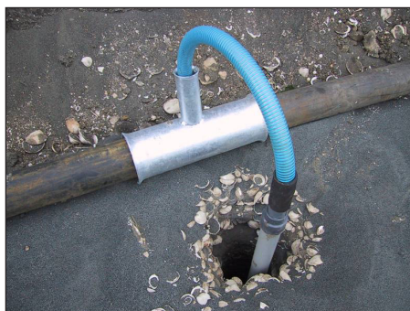
Figuur 3.7 – Bemaling met filterbuizen (Bron: VLARIO)
