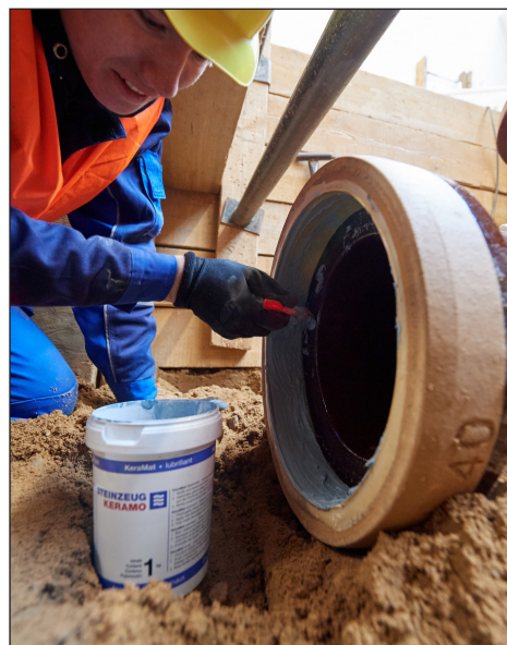
Figuur 5.20 – Aanbrenging van glijmiddel op gresbuis (Bron: Steinzeug-Keramo)
