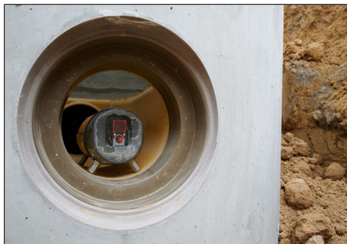
Figuur 5.22 – Laserapparaat in toegangspuit voor de aanleg aansluitende buisleiding (Bron: Steinzeug-Keramo)
