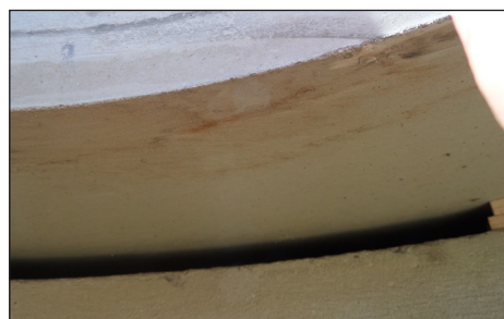
Figuur 8.14 – Zwevende dekplaat van geprefabriceerd gewapend beton op betonnen schacht (Bron: Lithobeton/VLARIO)
