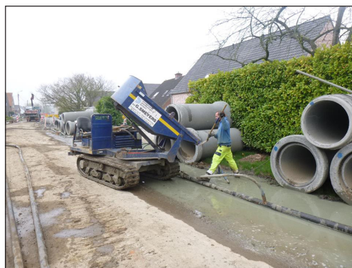
Figuur 3.6 – Opvullen van boorgat met filterzand voor het aanbrengen van de filterbuizen (Bron: VLARIO)
