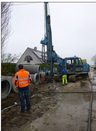
Figuur 3.5 – Boren van openingen in de bodem (Bron: VLARIO)
