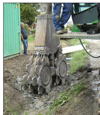
Figuur 4.18 – Grondfrees voor de aanbrenging van soilmixwanden als trillingsarme beschoeiing van bouwput of -sleuf (Bron: aannemer Soiltech-Soetaert)
