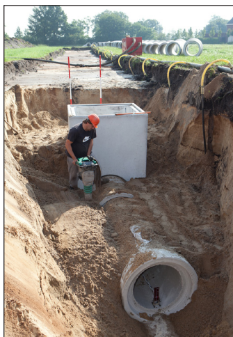
Figuur 6.5 – Verdichting van de omhulling van buizen
