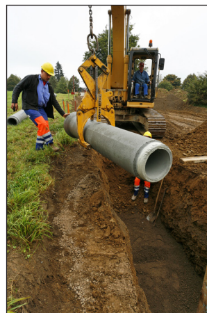
Figuur 2.22 – Geleiding van een buis bij het neerlaten in een sleuf (Bron: FEBE)
