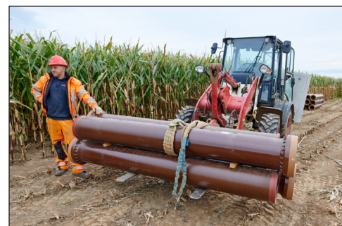
Figuur 2.12 – Hijzen met een vorkheftruck (Bron: Steinzeug-Keramo)
