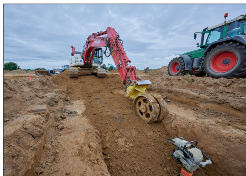
Figuur 6.8 – Aanvulling van de sleuf en verdichting van aanvulling met verdichtingswiel (Bron: Steinzeug-Keramo)
