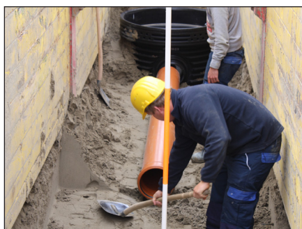
Figuur 4.11 – Beveiliging sleuf met stalen sleuvenbak (Bron: Kurio)
