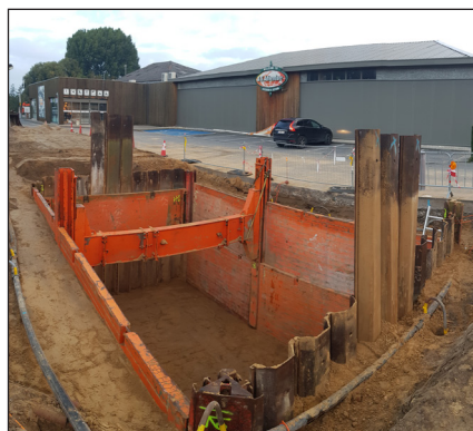
Figuur 4.16 – Rolsteunbeschoeiing (met dubbele kringsgeleiding) (Bron: Aannemer Vanlerberghe)
