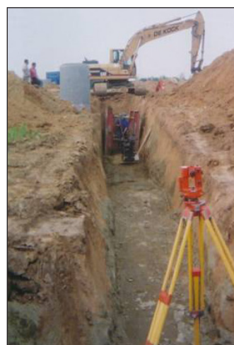
Figuur 5.21 – Nameting van de hoogteligging met een laserapparaat
