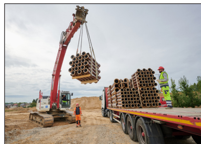
Figuur 2.17 – Hijzen met spanbanden (Bron: Steinzeug-Keramo)
