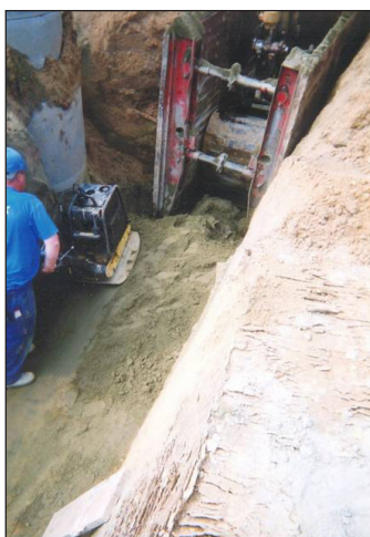
Figuur 6.5 – Verdichting van de omhulling van buizen
