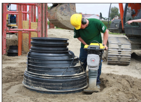
Figuur 8.23 – Verdichting rond toegangspuit van kunststof (Bron: Kurio)
