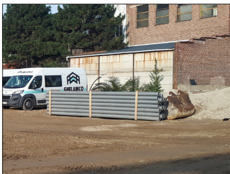
Figuur 2.24 – Stapelen van kunststofbuizen op de bouwplaats (Bron: Kurio)
