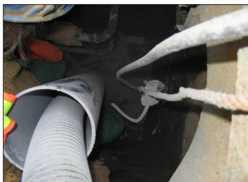
Figuur 3.3 – Pompen onder inspuiting van water
