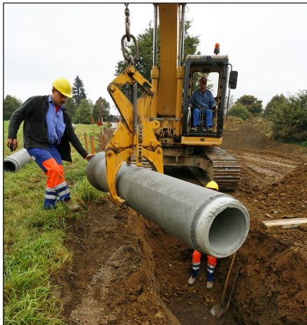
Figuur 2.9 – Hijzen van buis met buizenklem (Bron: FEBE)
