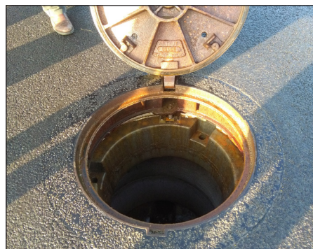
Figuur 8.20 – Traploos in hoogte regelbaar putdeksel in een bitumineuze verharding (Bron: VLARIO)
