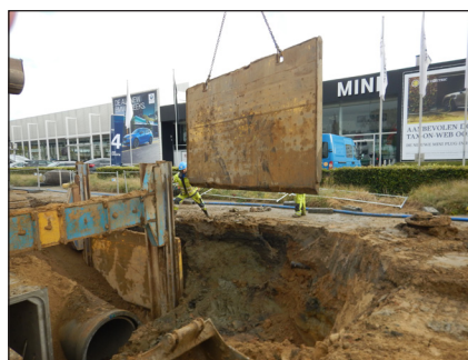
Figuur 4.12 – Aanbrenging van een stalen beschoeiingspaneel (Bron: VLARIO)
