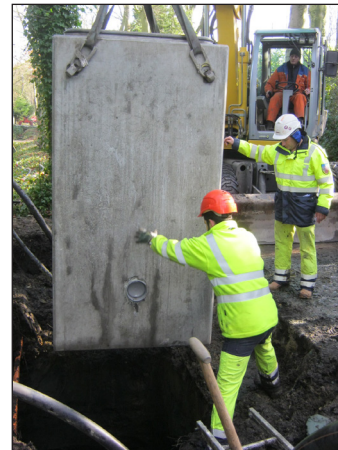
Figuur 8.10 – Neerlaten van een toegangspot van beton (Bron: VLARIO)
