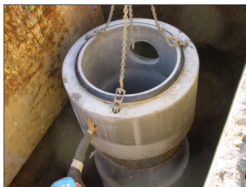
Figuur 2.21 – Hijzen met ketting (Bron: FEBE)
