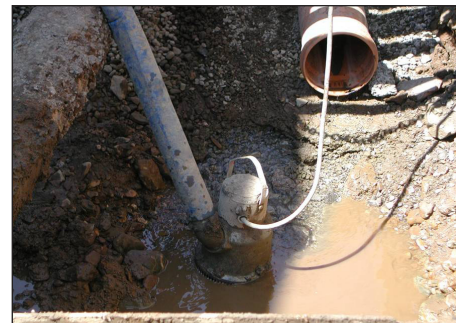
Figuur 4.20 – Voorbeeld van welvorming
