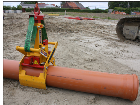
Figuur 2.10 – Hijzen met zelfsluitende buizenklem (Bron: Kurio)
