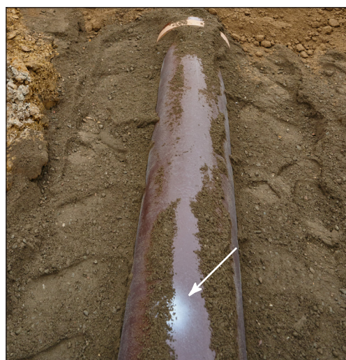
Figuur 5.33 – Witte stip op de kruin van een gresbuis die zich bij aanleg op 12 uur moet bevinden (Bron: VLARIO)
