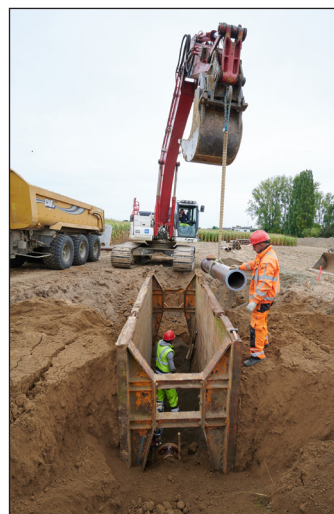
Figuur 4.10 – Aanleg buisleiding met sleuvenbak buiten de rijweg (Bron: Steinzeug-Keramo)
