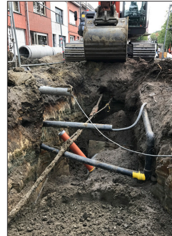
Figuur 4.19 – Kruisen van nutsleidingen (Bron: Bouwunie)
