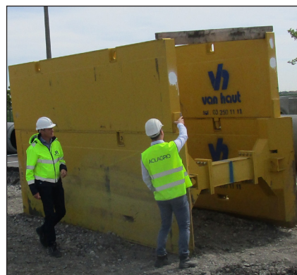
Figuur 4.13 – Sleuvenbak met verhoogde zijwanden (Bron: VLARIO)
