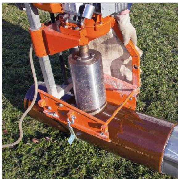
Figuur 7.15 – Boren van aansluitopening op een hoofdriool van gres (Bron: Steinzeug-Keramo)
