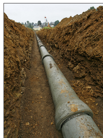
Figuur 4.3 – Aanleg van riolering op kleine diepte (< 2,00 m) in open sleuf zonder beschoeiing (Bron: FEBE)
