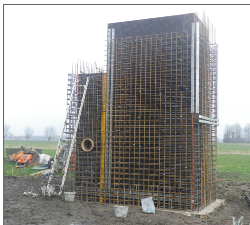
Figuur 3.11 – Afzinken van pompput in ter plaatse gestort gewapend beton (Bron: Aannemer Vanlerberghe)
