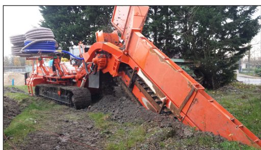
Figuur 3.9 – Horizontale bemaling (Bron: Aannemer Vanlerberghe)
