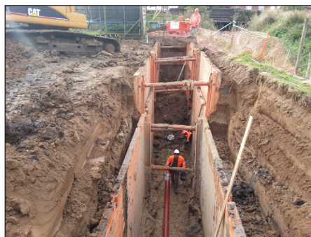
Figuur 4.14 – Beschoeiing met geleidebalksystemen en stalen wandpanelen (Bron: Aannemer Vanlerberghe)
