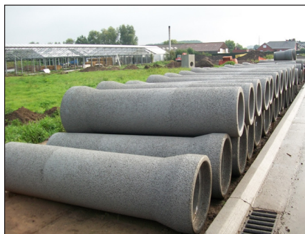
Figuur 2.26 – Stapelen van betonbuizen op de bouwplaats (Bron: VLARIO)
