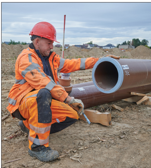
Figuur 5.20 – Aanbrenging van glijmiddel op gresbuis (Bron: Steinzeug-Keramo)
