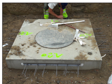
Figuur 8.15 – Plaatsing van een zwevende dekplaat op een put met aanstorting van platen in ter plaatse gestort gewapend beton (Bron: Lithobeton)
