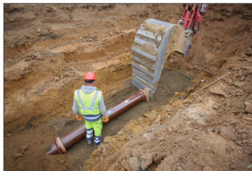
Figuur 5.30 – In mekaar duwen van de buizen door duwen met retrobak op houten balk (Bron: Steinzeug-Keramo)
