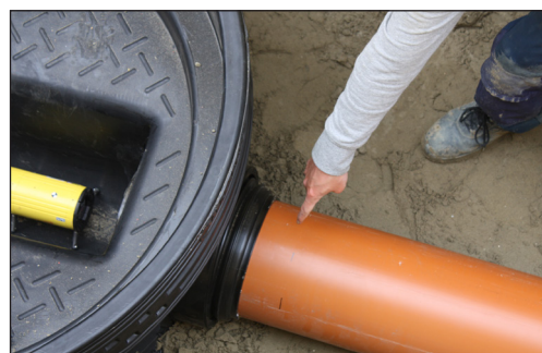
Figuur 5.14 – Aangebrachte zwarte markeerstrepen op spie-einde van buis voor visuele controle op insteekdiepte in de mof (Bron: Kurio)
