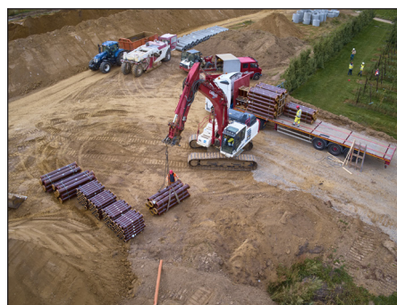
Figuur 2.23 – Opslag van gresbuizen op de bouwplaats (Bron: Steinzeug-Keramo)
