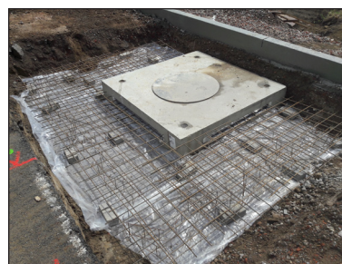
Figuur 8.15 – Plaatsing van een zwevende dekplaat op een put met aanstorting van platen in ter plaatse gestort gewapend beton (Bron: Lithobeton)
