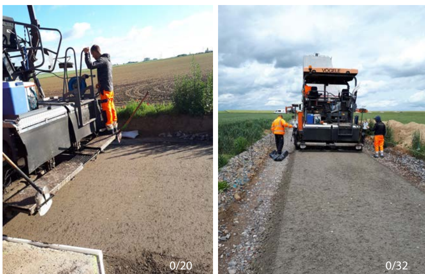
Figuur 9 – Aanblik van de twee soorten walsbeton na aanbrengring met de spreidmachine
