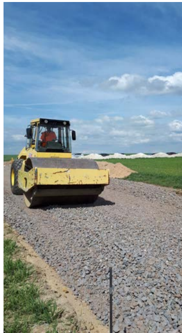
Figuur 4 – Korrelverdelingskromme van de ongebonden fundering en verdichting op de bouwplaats
