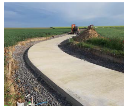
Figuur 5 – Aanbrenging van rijk betonmengsel en aanblik na verharding
