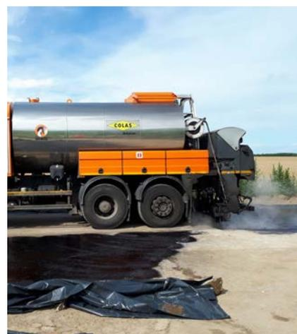
**Figure 10 – Compactage du BSC puis protection par épandage d'une émulsion de bitume et aspect final après simple gravillonnage**
