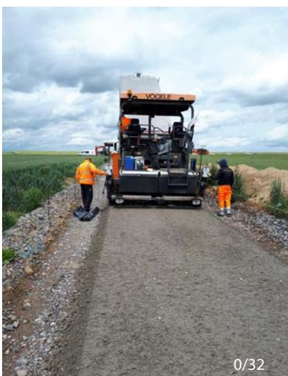
**Figure 9 – Aspect des deux BSC après mise en œuvre à la finisseuse**
