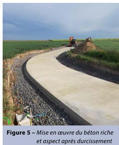
Figure 5 – Mise en œuvre du béton riche et aspect après durcissement
