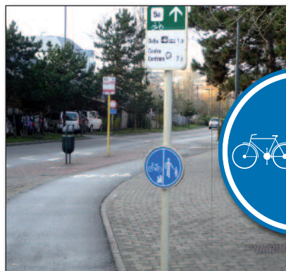
Figure 1 – Piste cyclo-piétonne D9 (pavés béton pour les piétons et enrobé noir pour les cyclistes)
