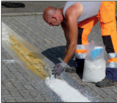
Figure 3 – Dispersion des granulats blancs sur la résine encore liquide
