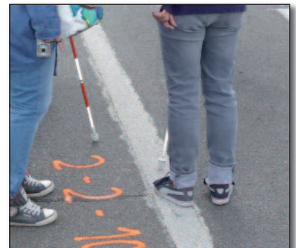
Figure 8 – Manque de linéarité du marquage après mise en œuvre
