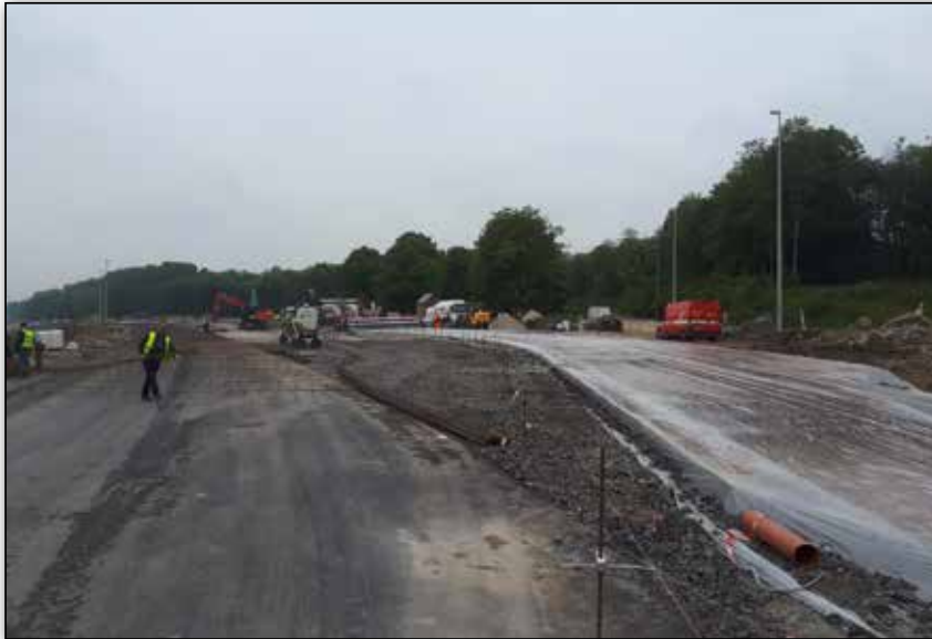
Figure 1 – Mise en oeuvre de planches expérimentales en béton armé continu à hauteur de l'autoroute A7 (en direction de Mons)
