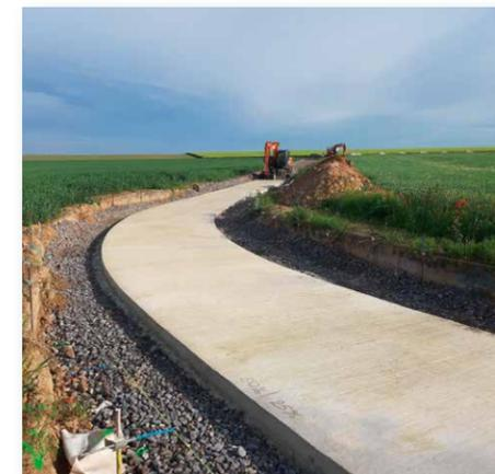
Les bétons riches ont été mis en œuvre au slipform, les bétons contenant des recyclés se compactant de façon tout à fait comparable au béton de référence ne contenant que du grès. Les **essais de compression** montrent que les résistances obtenues sur le chantier sont plus faibles que celles mesurées en laboratoire. Cependant, cette diminution de résistance est plus marquée pour le béton de grès que pour les bétons contenant des recyclés et semble liée à une teneur effective en eau trop élevée.
