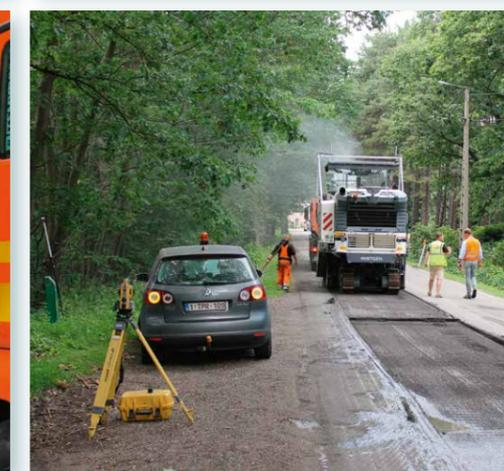
En **2019**, le CRR a organisé en collaboration avec l'AWV, Topcon, Top-Off et Colas un **projet de démonstration de fraisage 3D**. Il s'agit d'une nouvelle technologie qui peut aider à améliorer l'uni lors de la réfection de revêtements bitumineux. Un bon uni est en effet d'une importance cruciale pour la sécurité et le confort des usagers de la route.
