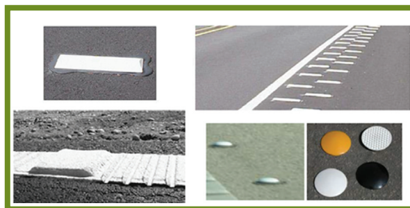
Figuur 2 – Overzicht van producten gebruikt voor rammelstroken met positief reliëf (Rosey & al, 2011) [5]
