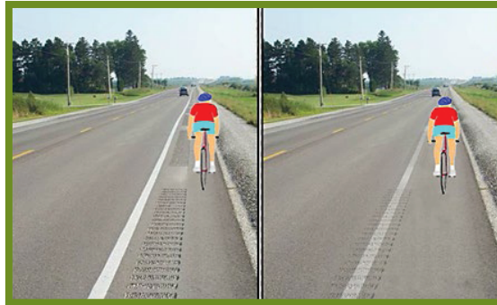
Figuur 13 – Rammelstroken in de berm versus rammelstroken op de markering
