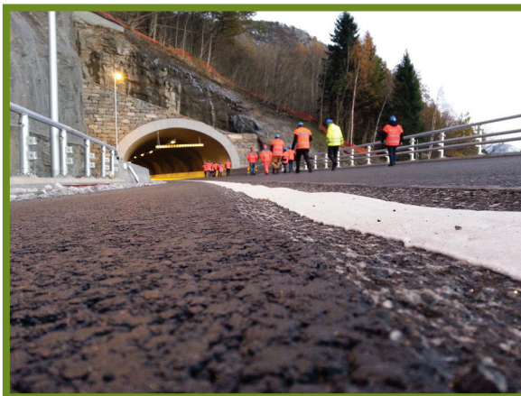
Figuur 14 – Rammelstroken met sinusvormig profiel bij het naderen van en in een tunnel in Noorwegen (foto's OCW)
