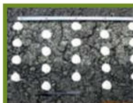
**Figure 12** – AD5 (4 points/ longueur; pas entre 2 bandes: 10 cm + 10 cm; épaisseur 3 mm)
