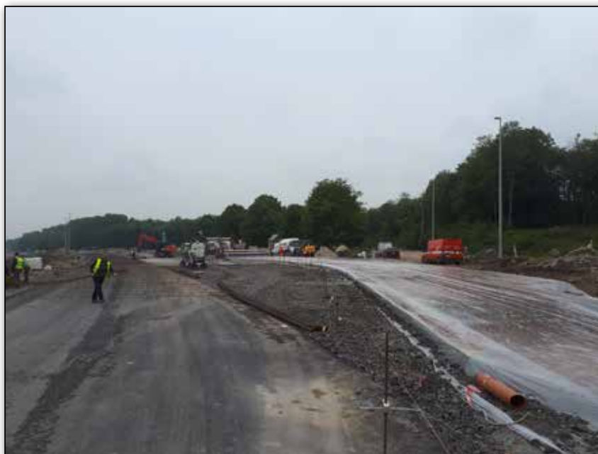
Figuur 1 – Aanleg van proefvakken in doorgaand gewapend beton ter hoogte van snelweg A7 (in de richting van Bergen)
