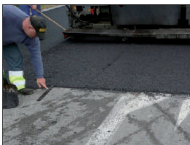
Figure 3.10 – Raccordement au revêtement existant
