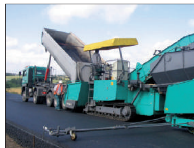
Figure 3.30 – Alignement longitudinal du finisseur
