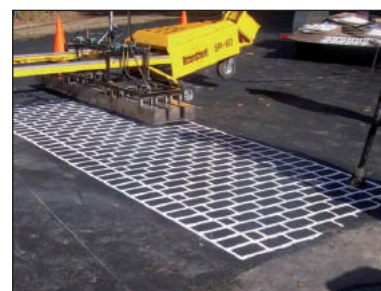
Figure 4.9 – Machine de réchauffement des enrobés
