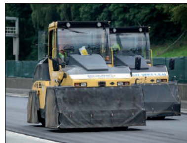
Figure 3.35 – Bâches de protection d'un compacteur à pneus
