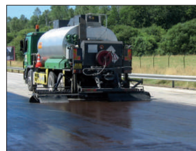
Figure 3.6 – Couche de collage en cours de pose
