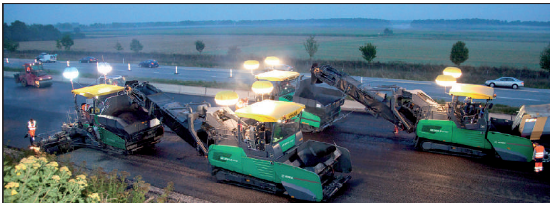
Figure 2.6 – Travaux de nuit
