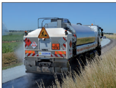
Figure 1.8 – Répandeuse de grande capacité
