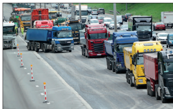
Figure 2.4 – Véhicules en excès sur chantier
