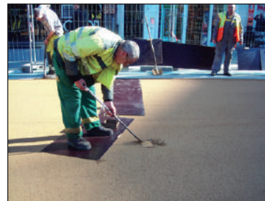
Figure 4.6 – Utilisation de plaques en bois
