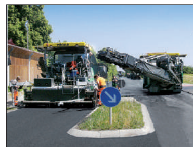
Figure 1.56 – Alimentation latérale par l'alimentateur
