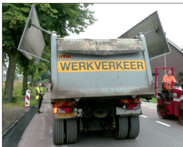
Figure 1.3 – Benne avec panneaux isolants
