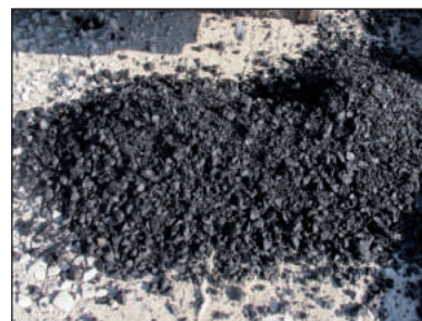
Figure 3.19 – Enrobé déversé à côté de la trémie
