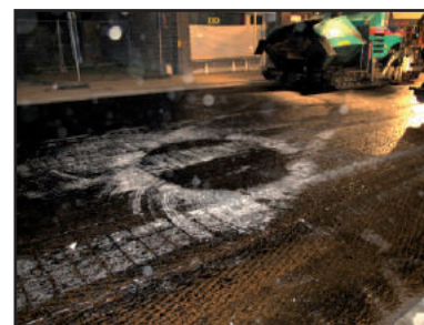
Figure 2.7 – Arrachage de la couche de collage
