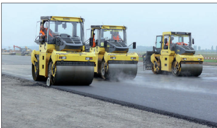
Figure 1.63 – Trois compacteurs tandem
