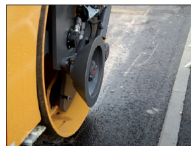
Figure 3.45 – Compactage à l'aide d'un cylindre latéral
