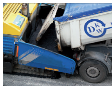
Figure 3.13 – Chargement du finisseur
