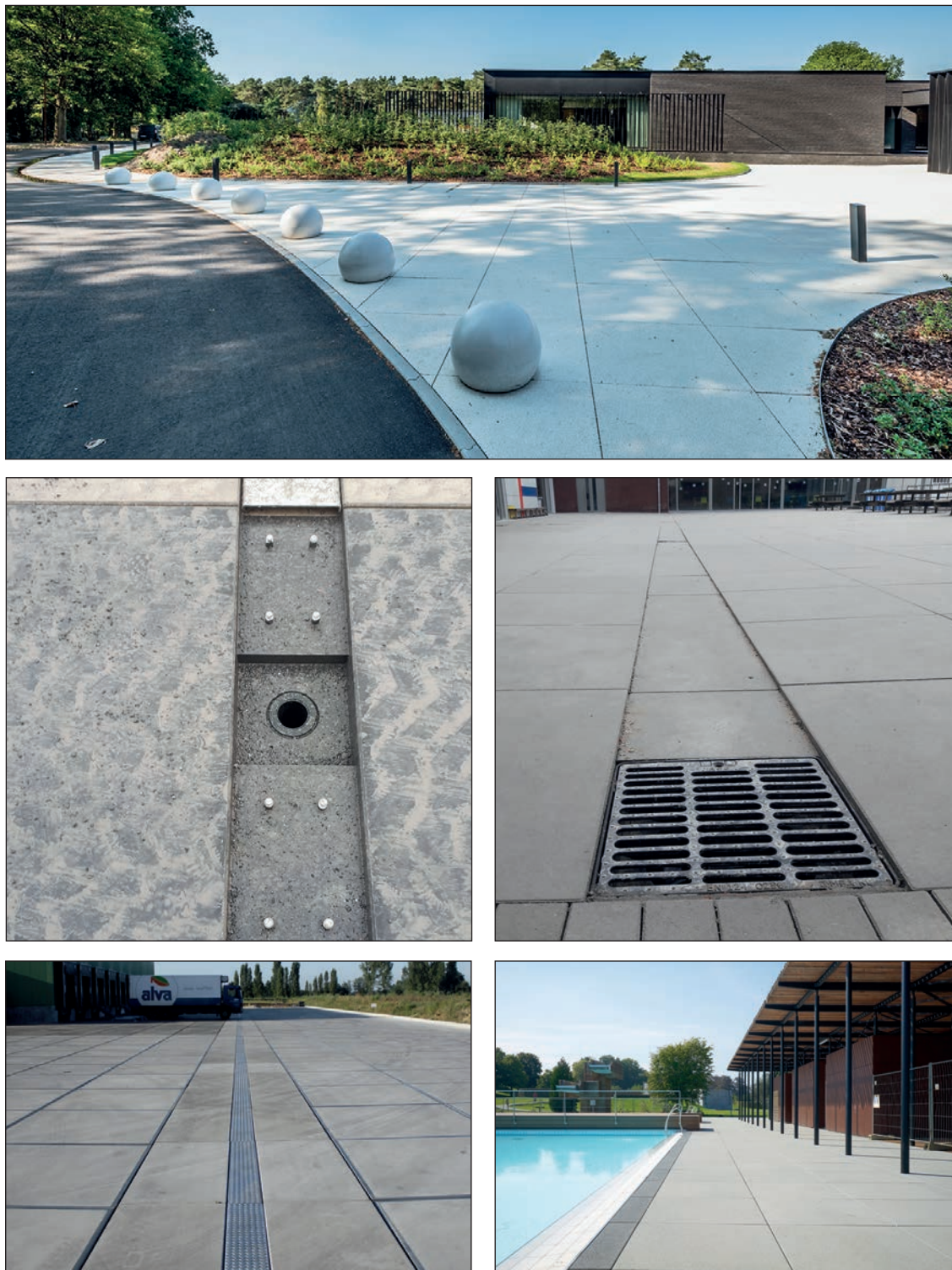
Figuur 4.24 – Aandacht voor afwerking aan de randen en rond singuliere punten, voor verzagen op kruispunten en in bochten met aanbrengen van velling, en voor detailafwerking, eventueel gebruik makend van speciale vormen
