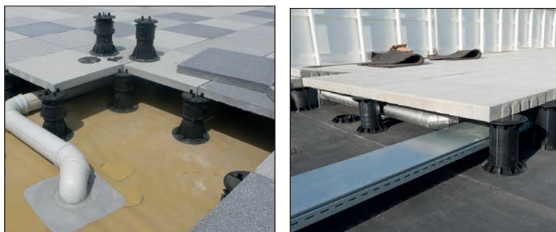
Figuur 4.13 – Plaatsing op tegeldragers als flexibel en modulair systeem
