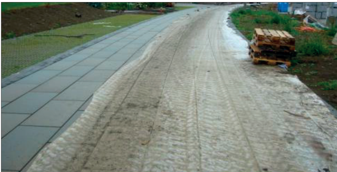
Figuur 4.10 – Bescherming van grootformaattegels met geotextiel om vervuiling tijdens de plaatsing te vermijden
