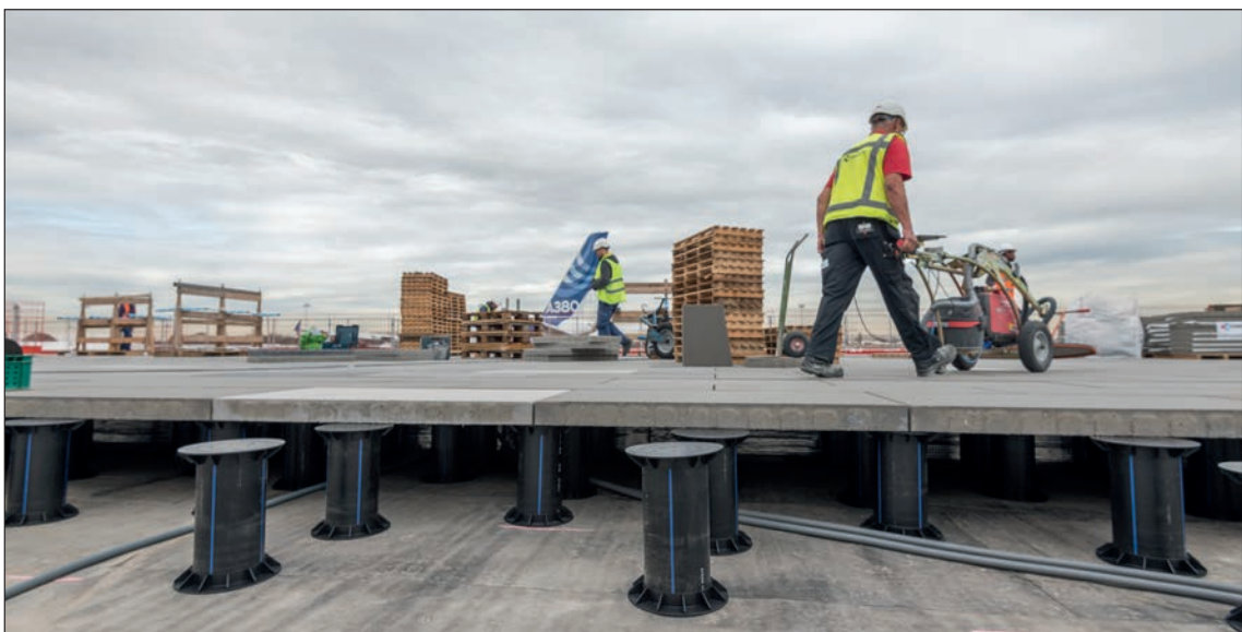
Figuur 7.5 – Dakconstructie met plaatsing op tegeldraggers
