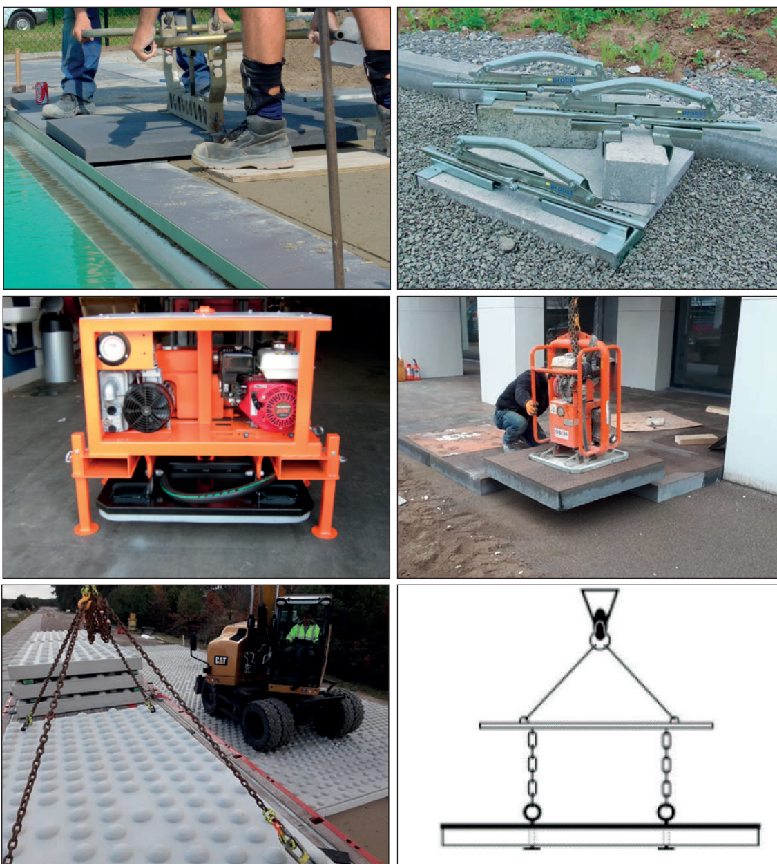
Figuur 4.8 – Verschillende manieren voor het plaatsen van grootformaattegels en geprefabriceerde betonplaten: mechanische klem, vacuümtoestel of hijsseutels
