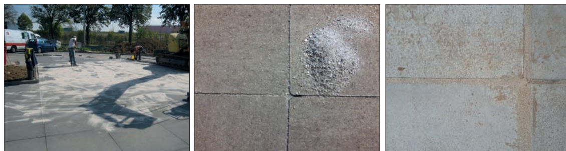
Figuur 4.12 – Invoegen met gepast materiaal zodanig dat een volledige vulling van de voegen wordt verkregen
