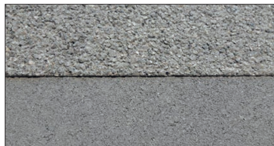
Figuur 5.7 – Vergelijking tussen onbehandeld (onder) en uitgewassen (boven) betonoppervlak
