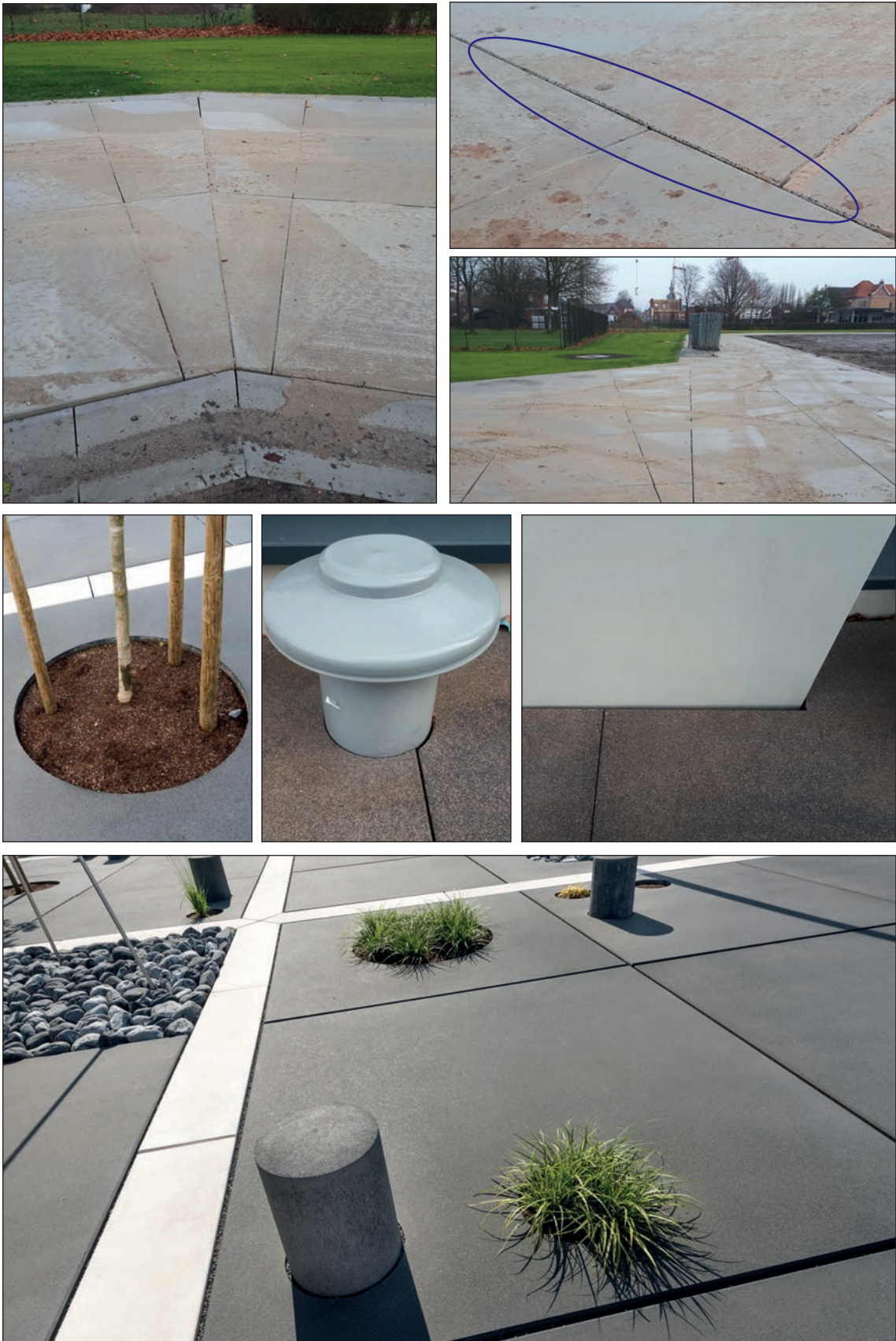
Figuur 4.24 (vervolg) – Aandacht voor afwerking aan de randen en rond singuliere punten, voor verzagen op kruispunten en in bochten met aanbrengen van velling, en voor detailafwerking, eventueel gebruik makend van speciale vormen
