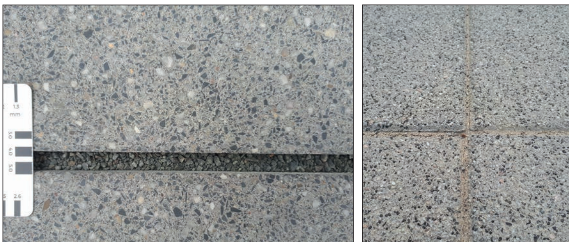
Figuur 8.1 – Regelmatige inspectie van de toestand van de voegen
