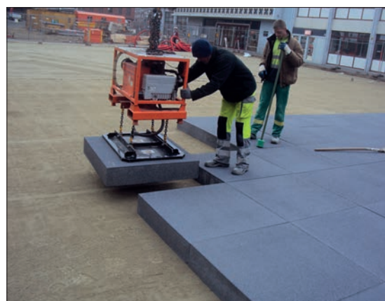
Figuur 4.5 – Plaatsing en verwerking van een straatlaag (nivelleren met een rei) in geval van grootformaattegels
