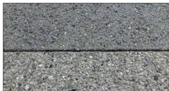
Figuur 5.9 – Verschillen tussen gekogelstraald (boven) en uitgewassen (onder) betonoppervlak
