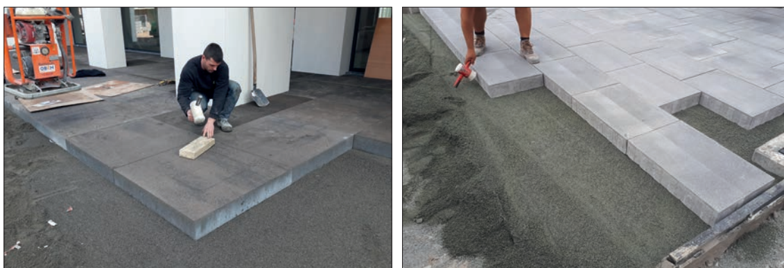
Figuur 4.7 – Wegwerken van oneffenheden met kunststofhamer en houten plank
