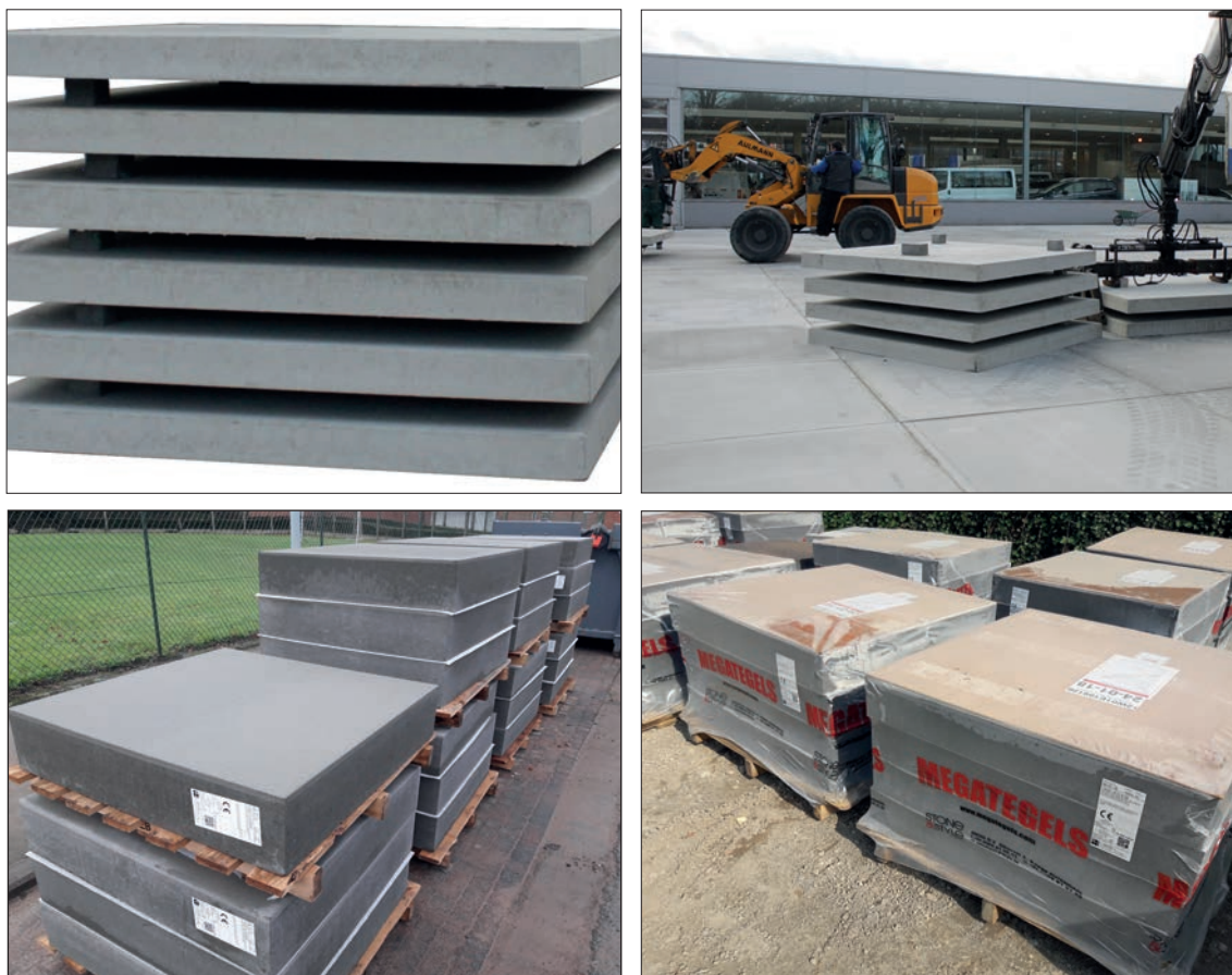
Figuur 4.1 – Aandacht voor lossen en stapelen van geprefabriceerde platen en grootformaattegels in beton
