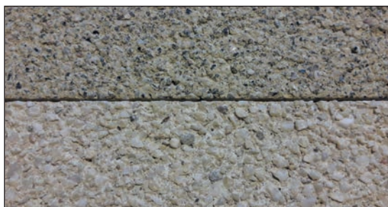
Figuur 5.6 – Voorbeeld van grof (onder, op basis van kwarts 2-4 mm) en fijn (boven, op basis van graniet, 2-4 mm) uitgewassen betonoppervlak
