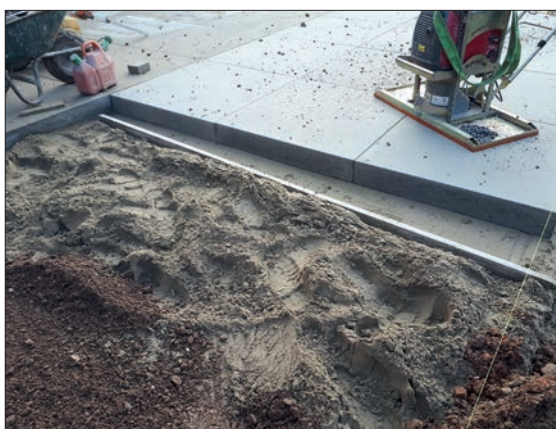
Figuur 4.5 – Plaatsing en verwerking van een straatlaag (nivelleren met een rei) in geval van grootformaattegels
