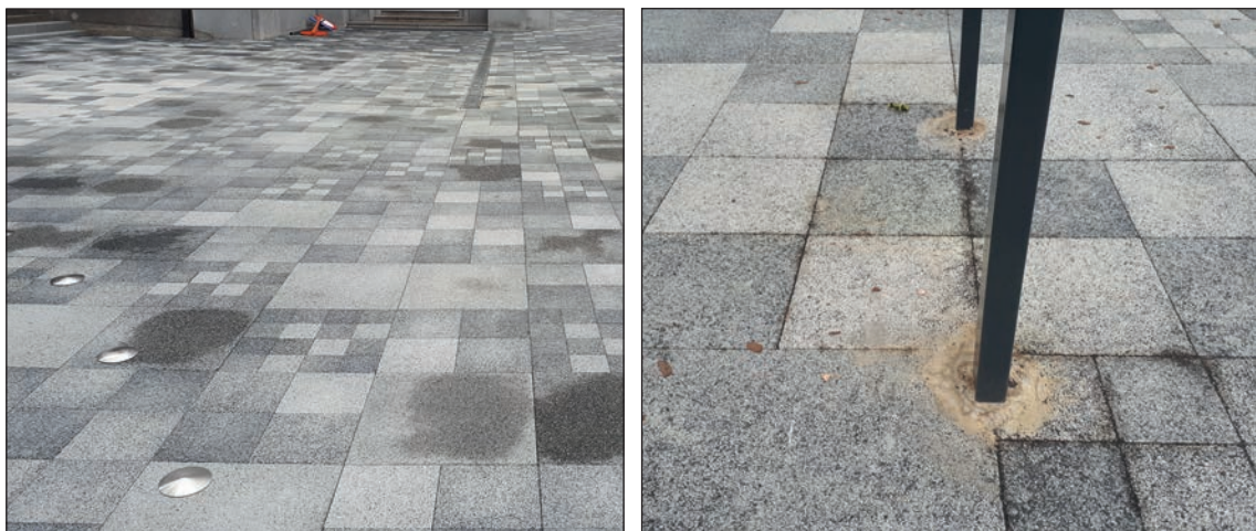
Figuur 8.3 – Ontwerp afstemmen op toekomstig beheer door demonteerbare obstakels en/of voldoende afstand ertussen aan te houden
