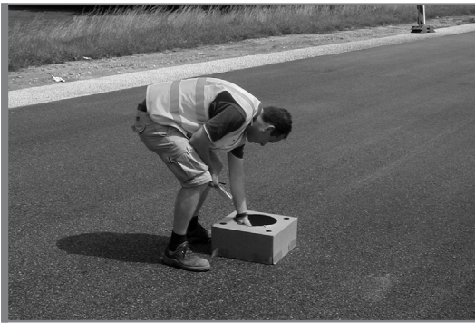
Foto A.1.3 Temperatuurmeting in het midden van de asfaltstrook
