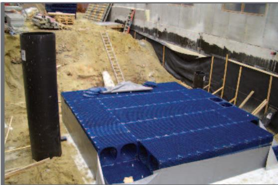
**Figure 2.63** Blocs de stockage pour bassin de rétention
