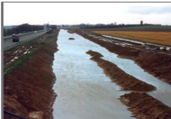
**Figure 3.2** *Fond de coffre non protégé et non drainé durant un arrêt des travaux*
