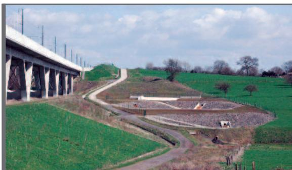
Figure 2.56 Exemple de bassin d'orage (ligne TGV Liège-Allemagne – viaduc de Battice)
