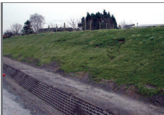
**Figure 2.14** Erosion - Décrochement de terre végétale
