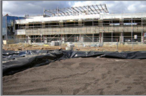
**Figure 2.61** Bassin tampon rempli d'argile expansée
