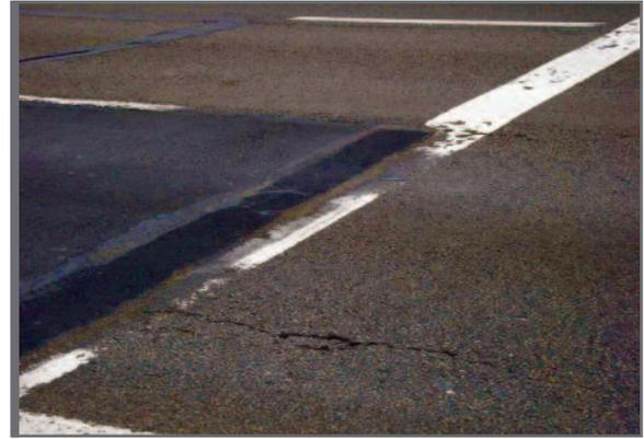
**Figure 5.4** Exemples de dégradations de surface liées au mauvais drainage
