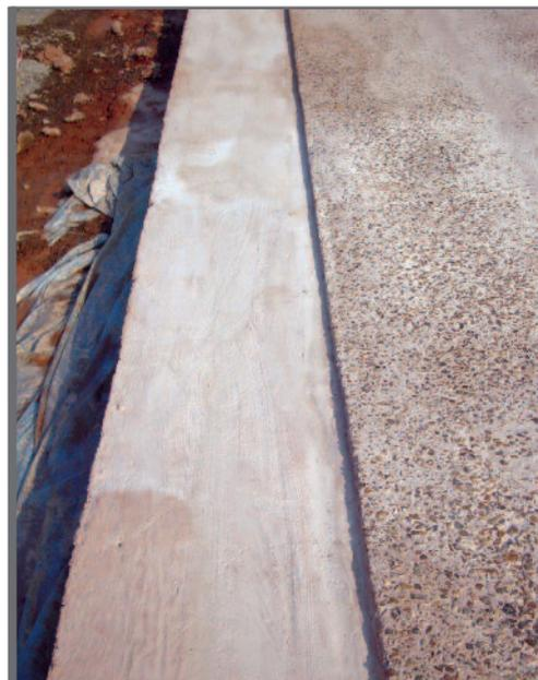
**Figure 2.17** Filet d'eau en béton mis en œuvre avec la dalle
