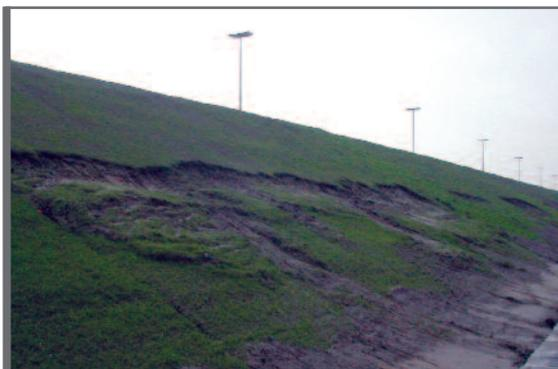
**Figure 3.3** Erosion de talus
