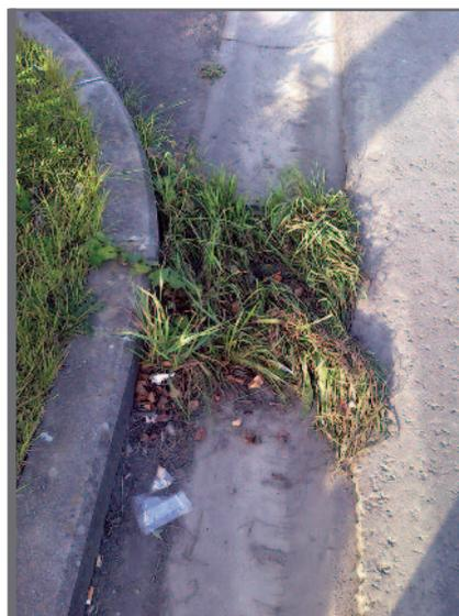
Figure 4.3 Filets d'eau mal entretenus
