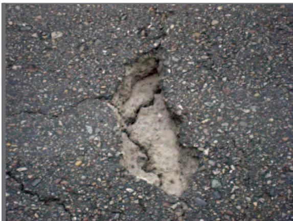
**Figure 5.6** Autre exemple de dégradations de surface liées au mauvais drainage
