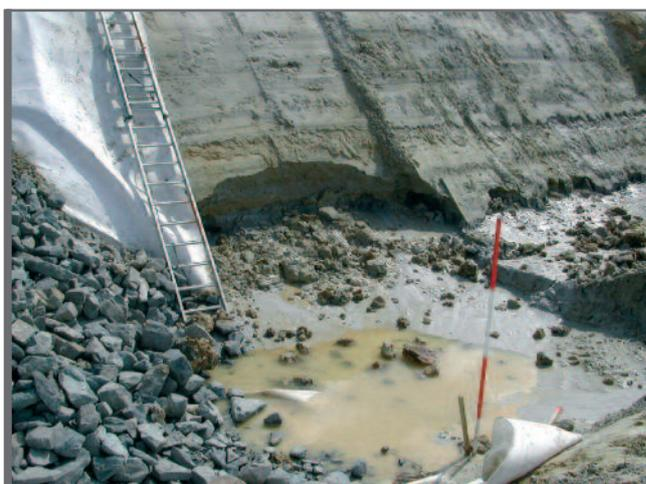
**Figure 2.30** Instabilité due à la nappe affleurante
