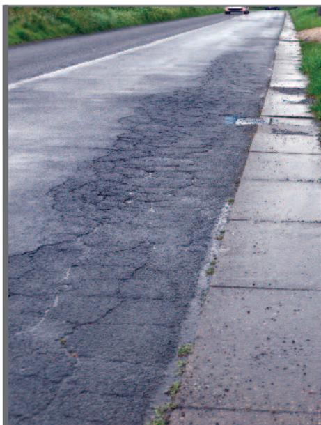
**Figure 5.2** Exemple de dégradations liées à la mise en place d'un élément linéaire en béton bloquant l'eau
