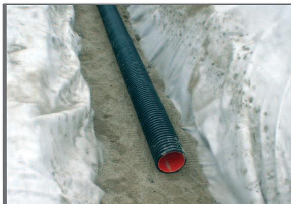
**Figure 2.49** Mise en place de la tranchée drainante – géotextile de filtration
