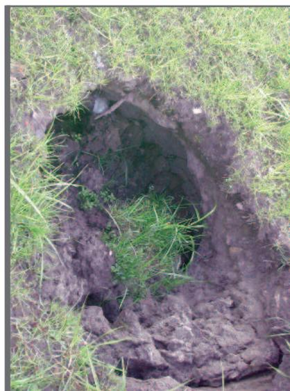
**Figure 3.5** Erosion dans un talus
