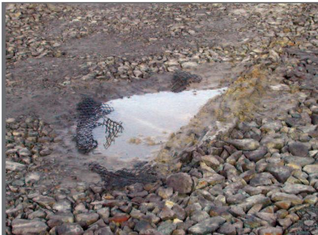
**Figure 1.12** Remontée des particules fines
