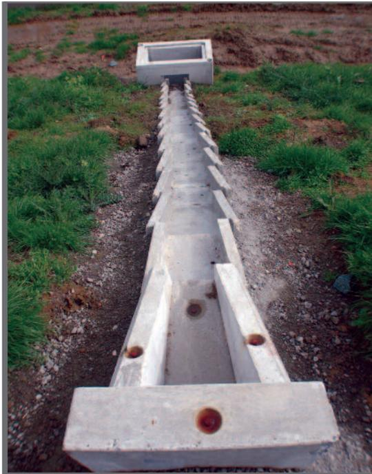
Figure 2.11 Caniveau de talus à cascades (talus de remblai)
