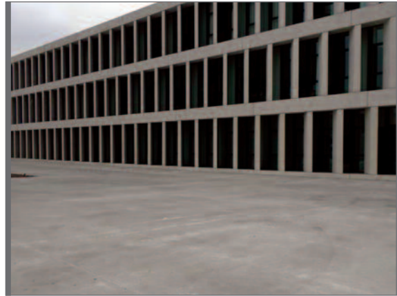
Place en dalles de béton pour l'hôpital Groeninge à Courtrai (Baumschlager & Erbele architecten)
