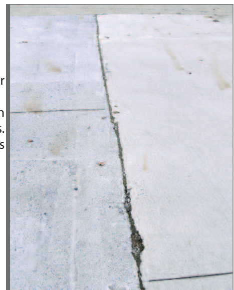
Figure 6.7 Effritement des lèvres des joints
