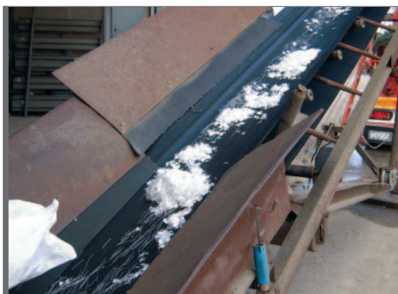
Figure 3.27 Ajout d'une combinaison de fibres d'acier et de fibres synthétiques dans le béton frais
