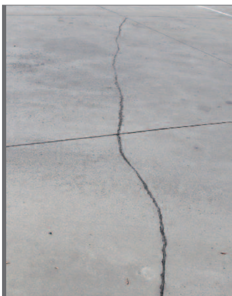
Figure 6.12 Scellement de fissures
