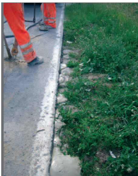
Figure 6.11 Injection d'un coulis de ciment
