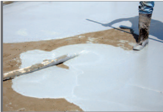
Figure 4.1 Couche d'usure posée frais sur frais
