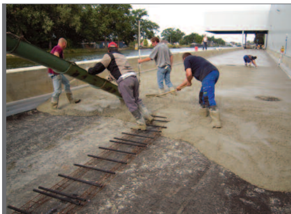
Figure 3.17 Pose de béton entre coffrages fixes sans compactage complémentaire
