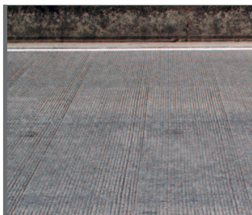
Figure 3.22 Texture obtenue par striage transversal
