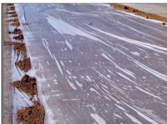
Figure 3.26 Protection du béton à l'aide d'une membrane plastique
