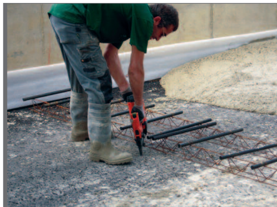
Figure 3.5 Fixation de berceaux dans la fondation pour la pose de goujons dans un joint de retrait transversal
