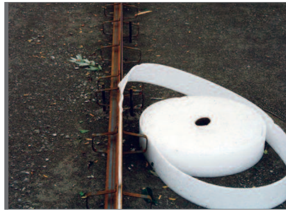
Figure 3.6 Système de joint comme joint de dilatation
