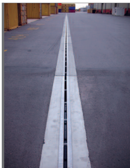
Figure 3.30 Caniveau à fente
