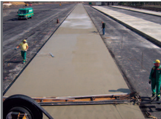
Figure 1.8 Dalles de béton goujonnées sur couche bitumineuse intermédiaire
