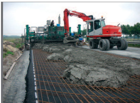
Figure 1.4 Revêtement en béton armé continu
