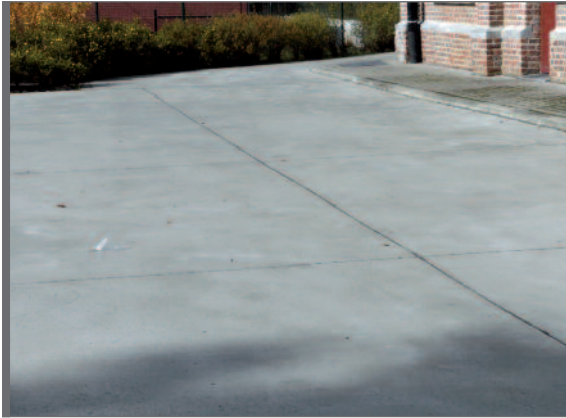
Figure 3.1 Joints de retrait/flexion transversaux et longitudinaux
