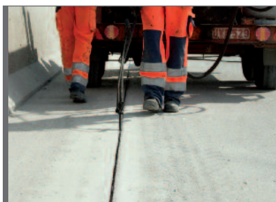
Figure 3.8 Produit de scellement coulé à chaud
