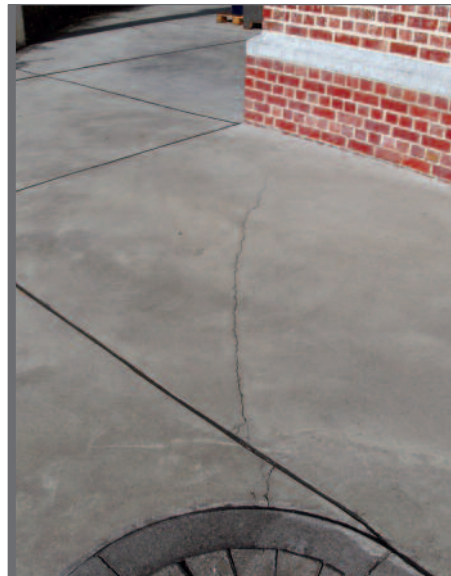
Figure 6.1 Fissure due à un mauvais schéma d'implantation des joints
