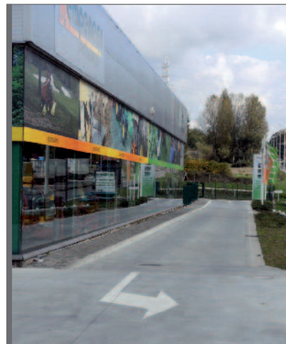
Figure 2.6 Accès de parking pour voitures particulières
