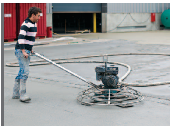
Figure 3.19 Finition hélicoptère à la talocheuse
