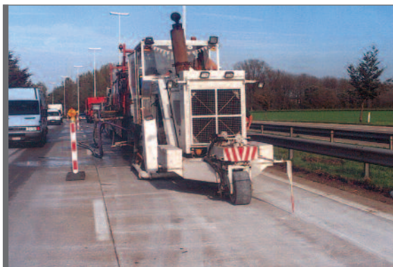
Figure 6.15 Meulage à l'aide de disques diamantés
