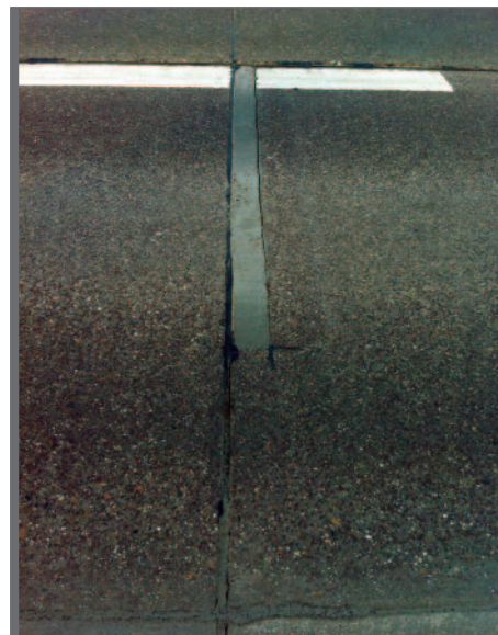
Figure 6.13 Réparation d'un bord de dalle avec du mortier
