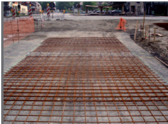
Figure 1.2 Dalle en béton armé
