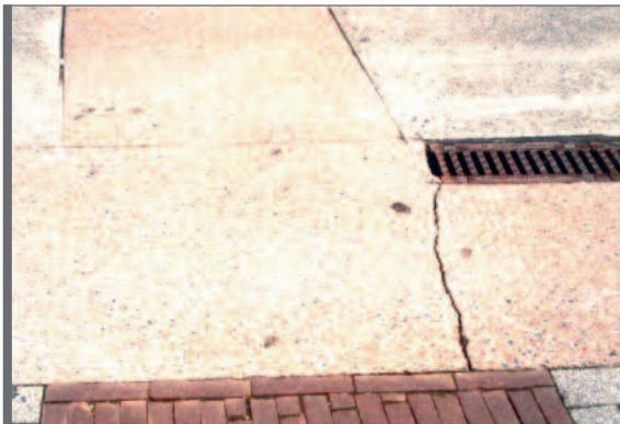
Figure 6.1 Fissure due à un mauvais schéma d'implantation des joints
