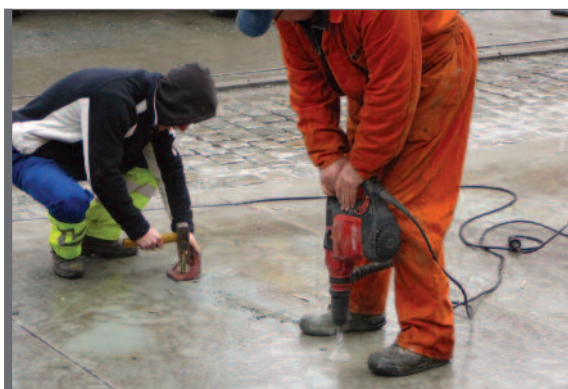
Figure 6.10 Forage de trous d'injection
