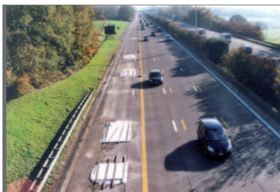
Figure 6.14 Recouvrement des réparations par des plaques isolantes pour un durcissement plus rapide
