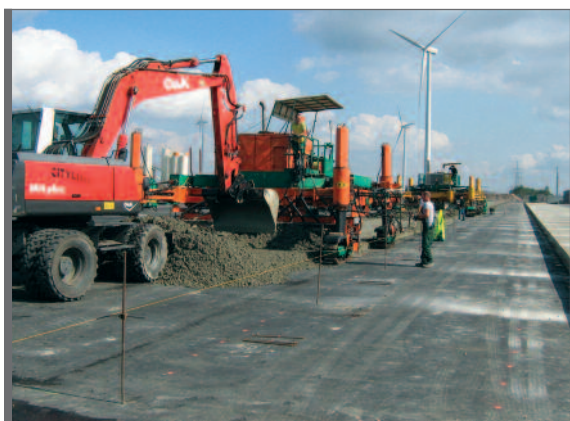
Figure 3.15 Mise en œuvre de béton bicouche au moyen d'une machine à coffrage glissant
