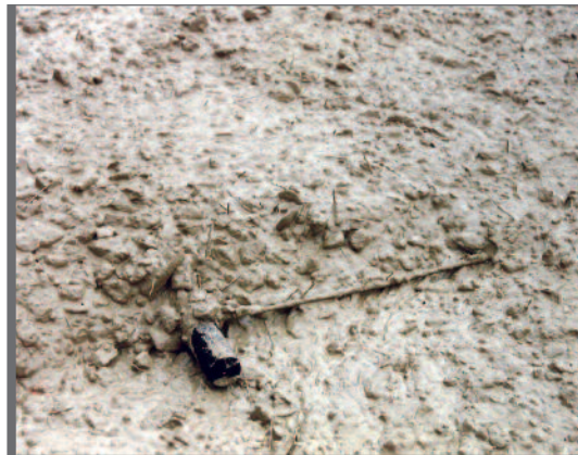
Figure 3.14 Béton renforcé de fibres d'acier dans une dalle de béton goujonnée
