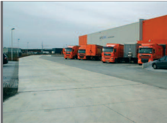
Lommel: parc industriel Balendijk
