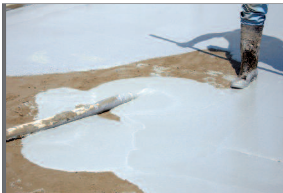
Figure 6.17 Pose d'une couche anti-usure frais sur frais
