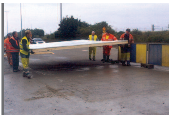
Figure 3.28 Pose d'une plaque isolante sur le béton
