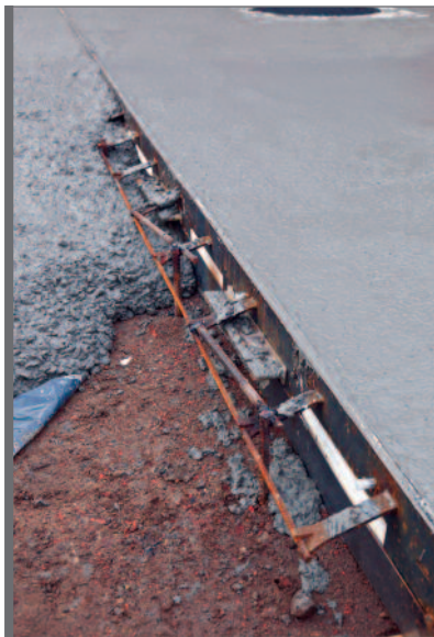
Figure 3.7 Système de joint préfabriqué (profil droit)
