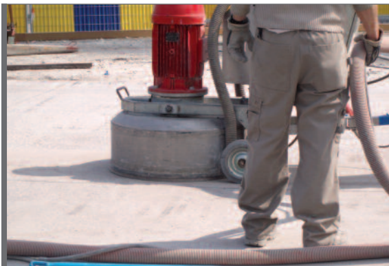
Figure 6.16 Polissage à l'aide de disques diamantés
