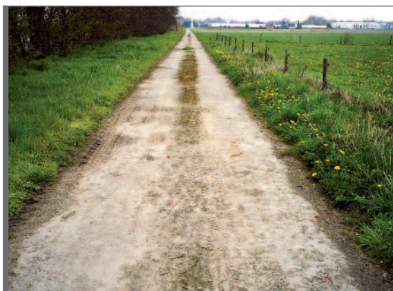
Figure 1.5 Revêtement en béton sec compacté
