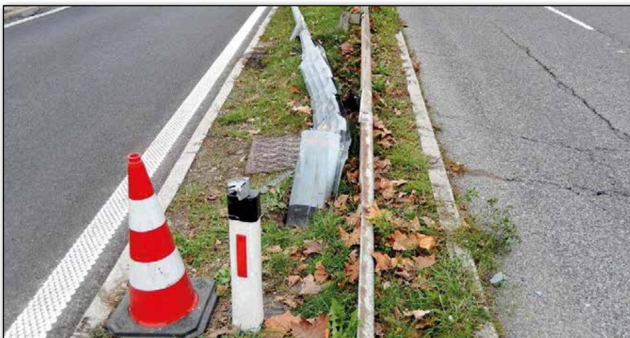
Figuur 1 – Aangereden botsvriendelijke paal (bron: Safety-Product)
