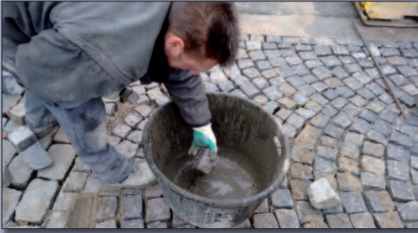
Figuur 4 – Dompelen van stenen in hechtmortel (links) en bovenaan afkitten van de uitzetvoegen met elastische voegvulling (rechts)
