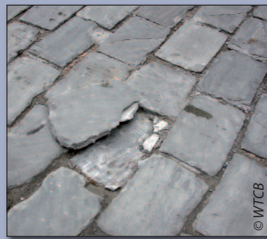
Figuur 1 – Voorbeelden van afsplijting of desintegratie van bepaalde natuursteensoorten onder klimatologische en/of verkeersbelasting
