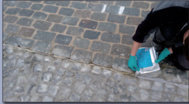
Figuur 4 – Dompelen van stenen in hechtmortel (links) en bovenaan afkitten van de uitzetvoegen met elastische voegvulling (rechts)
