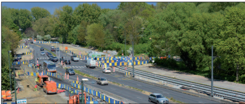
Overzicht van een fase in uitvoering, vanop de derde verdieping van het OCW-gebouw in Woluwe
