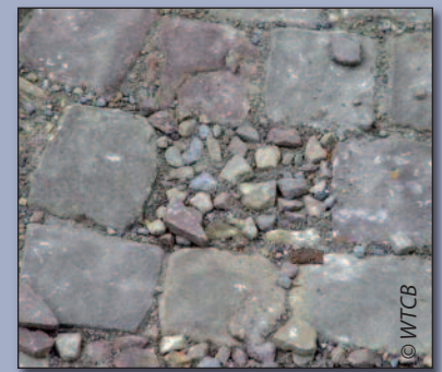
Figuur 1 – Voorbeelden van afsplijting of desintegratie van bepaalde natuursteensoorten onder klimatologische en/of verkeersbelasting
