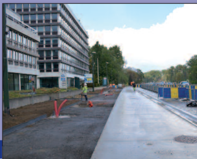
Herinrichting aan de bebouwde zijde. Van links naar rechts: (toekomstige) groenstrook, hier en daar met zitbanken; (toekomstig) trottoir; tweerichtingsfietspad (beton); parkeerstrook (straatkeien)
