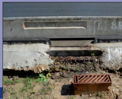
Uitgraving voor een wadi. De gleuf onder de trottoirband laat afvloeiwatervan de rijbaan door, terwijl de rioolkolk als overloop zal dienen
