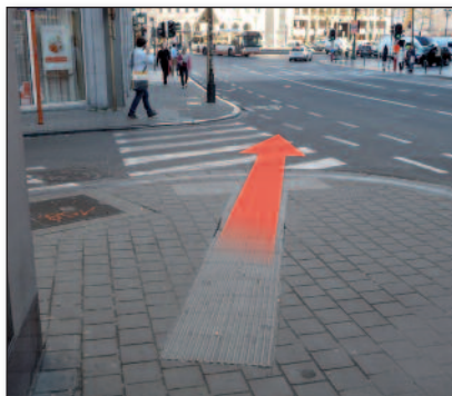
Figuur 2 – De ribbeltegels geleiden blinden en slechtzienden naar de rijbaan in plaats van naar de voetgangersoversteekplaats!
