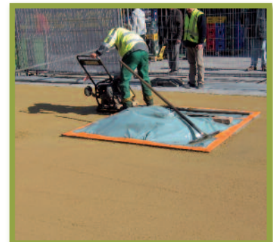
Figuur 9 – Bescherming van zones waar geen asfalt wordt aangebracht
