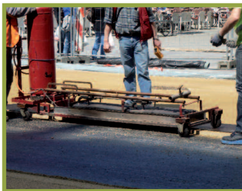
Figuur 10 – Verwarmen van asfaltranden met een verwarmingsbalk
