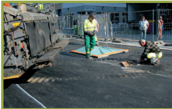
Figuur 6 – Bevuilding van en losrukken van de kleeflaag door werkverkeer
