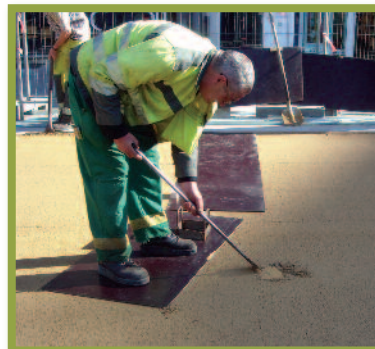
Figuur 8 – Bescherming van pas aangebracht asfalt met houten loopplanken
