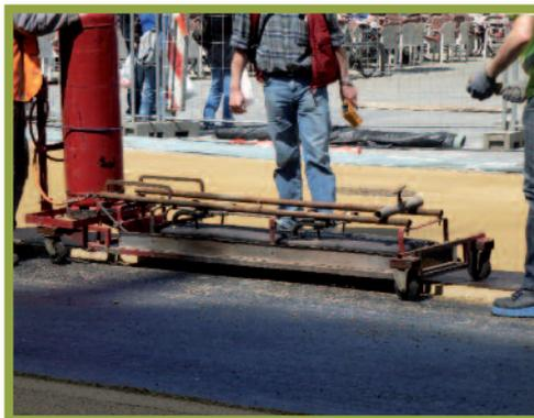
**Figure 10** – Utilisation d'une rampe de réchauffage pour réchauffer les bords de l'enrobé
