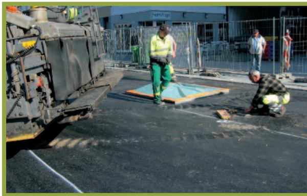
**Figure 6** – Salissures de la couche de collage par un engin de chantier
