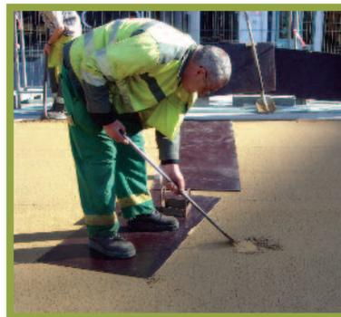
**Figure 8** – Utilisation de plaques en bois lors de la circulation sur chantier
