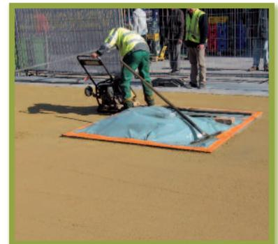
**Figure 9** – Protection des zones à ne pas revêtir
