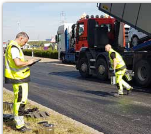
Figure 2 – Prélèvement d'échantillons pendant la mise en œuvre de sections expérimentales avec utilisation de produits régénérants sur la Steenlandlaan (Port d'Anvers) à Kallo/Beveren
