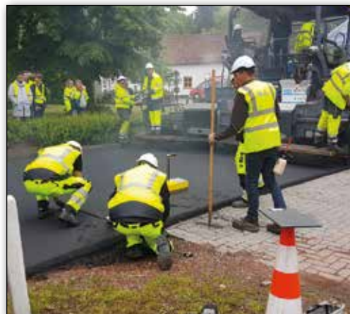
Figure 1 – Suivi de la pose des sections expérimentales avec utilisation de produits régénérants sur la N123 (Retie – Kasterlee) à Retie
