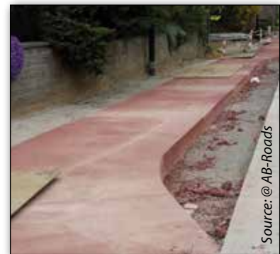
Figure 6 – Coefficient de planéité (CP 0.5 ) mesuré sur une piste cyclable, avec l'impact de l'arrêt de bus. La zone 1 a été réalisée de manière mécanique, la zone 2 manuellement
