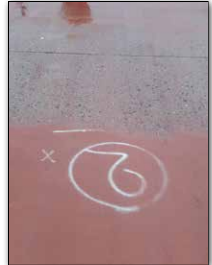
Figure 9 – Meulage avec disques diamantés pour rétablir l’uni (ligne pleine avant le meulage, ligne pointillée après le meulage des bosses)
