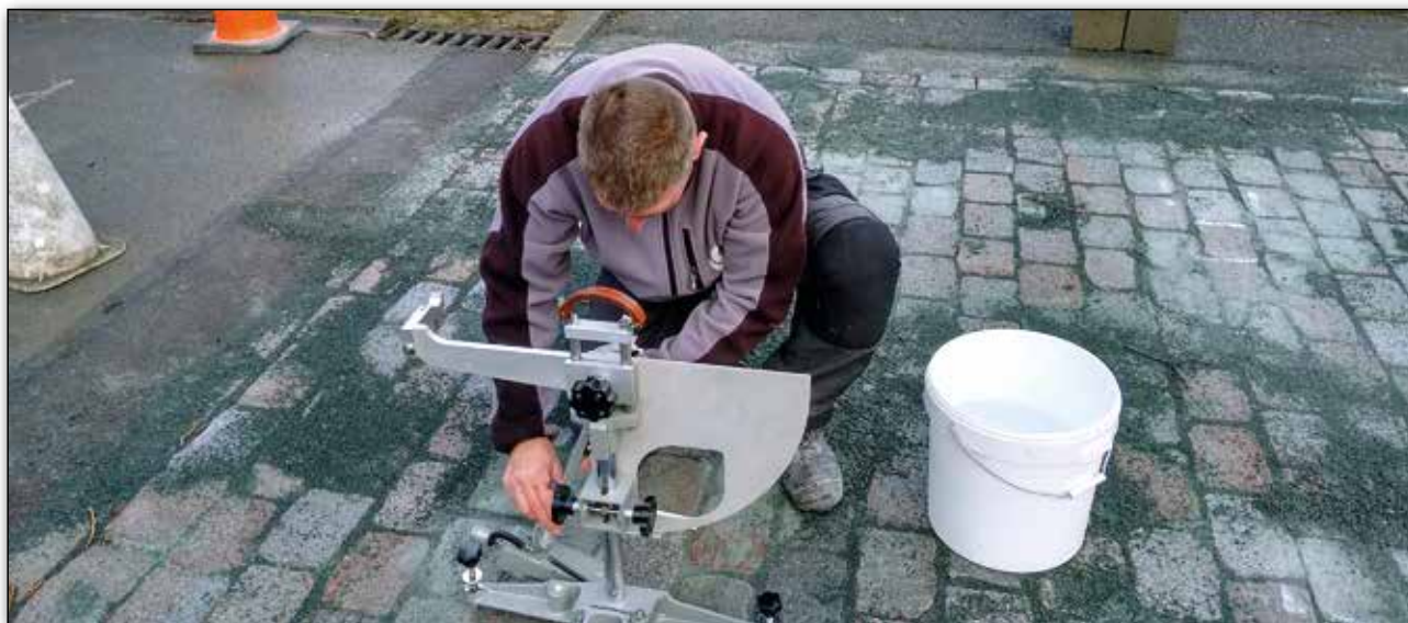
Figure 2 – Réalisation de mesures avec le pendule SRT sur les planches expérimentales de Sterrebeek
