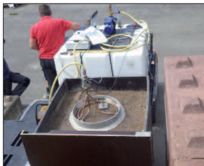
Figure 3 – Essai pilote permettant de mesurer la perméabilité sur base d'un essai double anneau
