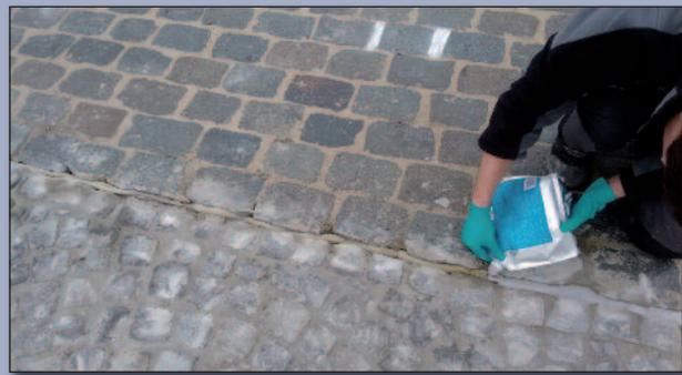
Figure 4 – Trempage des pavés dans du mortier d'accrochage (à gauche) et au-dessus, scellage des joints de dilatation avec matériau de jointoiement élastique (à droite)
