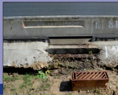
Travaux d'excavation pour une noue. La fente sous la bordure laisse passer l'eau de la chaussée, alors que l'avaloir servira de trop-plein
