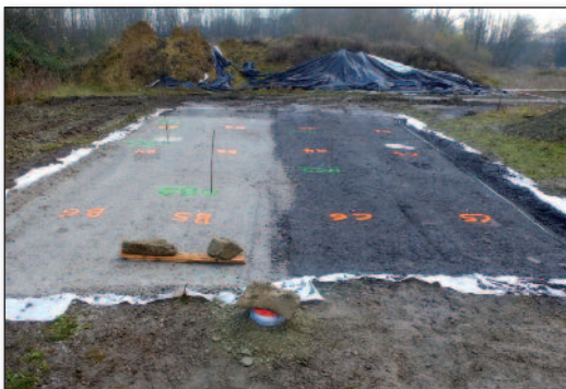
Figure 5 – La deuxième planche d'essais réalisée dans le cadre du projet APERRROUT a permis de comparer les performances de recyclés de béton (à gauche sur la photo) et de granulats calcaires (à droite sur la photo)
