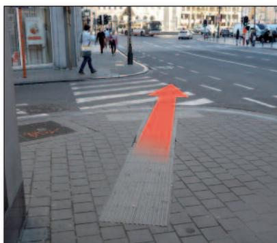
**Figure 2** – Les revêtements podotactiles striés guident les personnes déficientes visuelles vers la chaussée et non vers la traversée piétonne!
