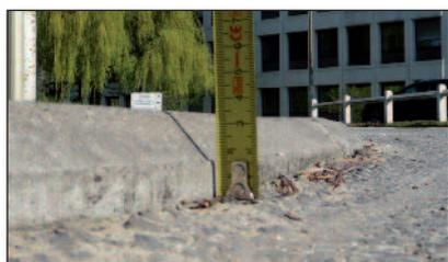
**Figure 1** – Jonction non conforme (ressaut vertical présent) à hauteur d'une traversée cyclable
