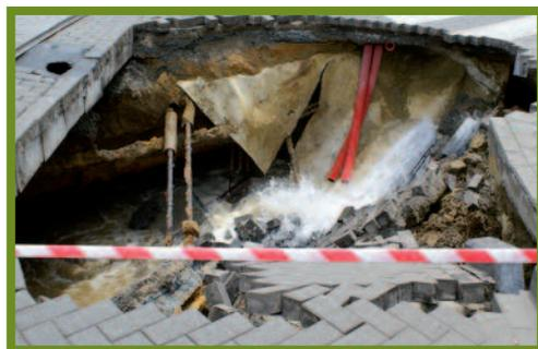
*Importants dégâts suite à l'effondrement d'une conduite*
