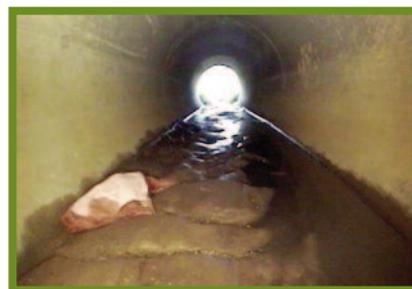
*Dépôts décantés suite à l'entrée de boue par un regard lors de la construction: recouvrir le regard peut engendrer des coûts supplémentaires*
